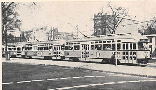
Semi-metro van Boston; een stel van 3 PCC-motorwagens op een afzonderlijke bedding, alvorens een tunnel te bereiken.
