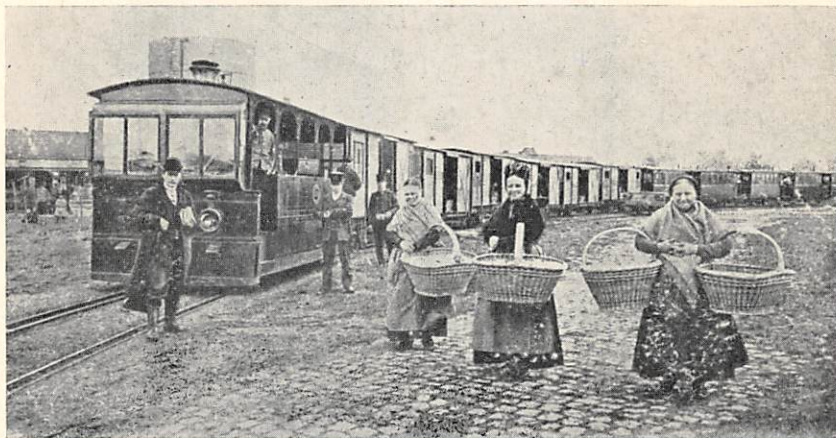
Een gemengde reizigerstrein te Mol, tussen het station N.M.B.S. en Mol-Donk, op een spoor met vier rails (1 m en 1,435 m).
