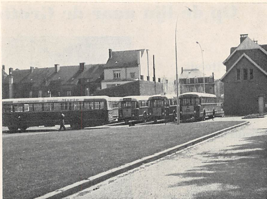
Men herkent nog nauwelijks het buurtspoorwegstation van Aarlen, gebouwd in 1907 en waar stoomlocomotieven en spoorauto's gemanoeuvreerd hebben tot in 1950.
