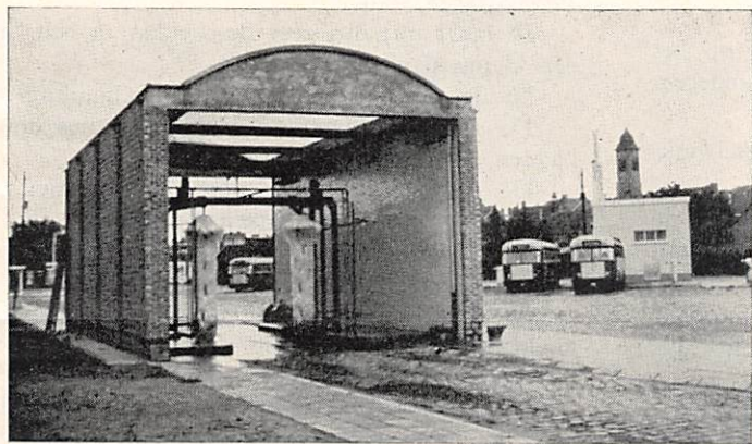
De installatie van de automatische wasinrichting.
