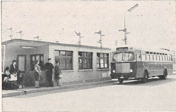
Daar de stelplaats van de buurtspoorwegen zich op meer dan twee kilometer van het spoorwegstation bevindt, heeft de N.M.V.B. tegenover het autobusstation een klein gebouw opgericht voor de dienst van de ontvangsten en voor het afleveren van abonnementen.
