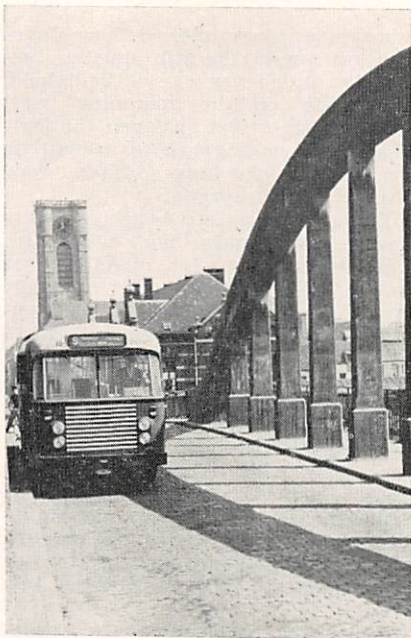
De autobus begeeft zich op de spoorwegbrug. Op de achtergrond onderscheidt men de kerk van St-Julien, die na de brand van 1817 werd heropgebouwd. De imposante toren dateert van 1462. Onze autobus rijdt in de richting van onze nieuwe stelplaats te Aat.
