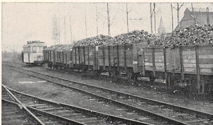
Een spoorauto brengt de wagons met beten op de sporen van het rangeerstation waar zij worden afgehaald door een stoommachine van de raffinaderij.
