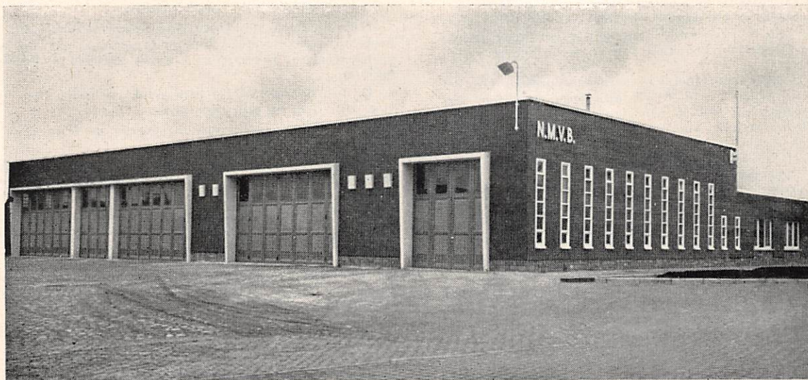
Garage voor autobussen in de stelplaats te Sint-Truiden.
