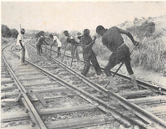
Het verschuiven van de rails gebeurde in een recordtijd.
