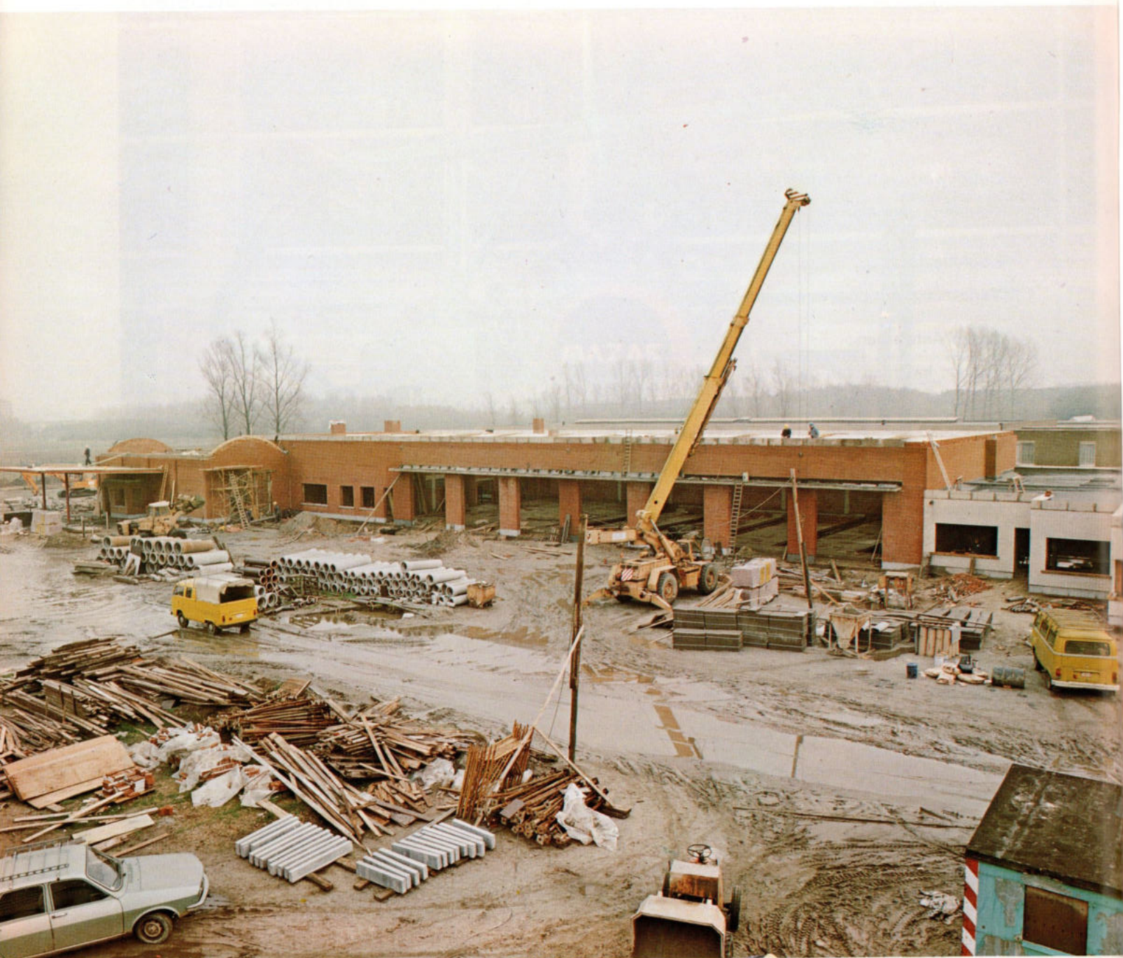
Werken te ST.-NIKLAAS-WAAS — Algemeen zicht op de werkplaats
