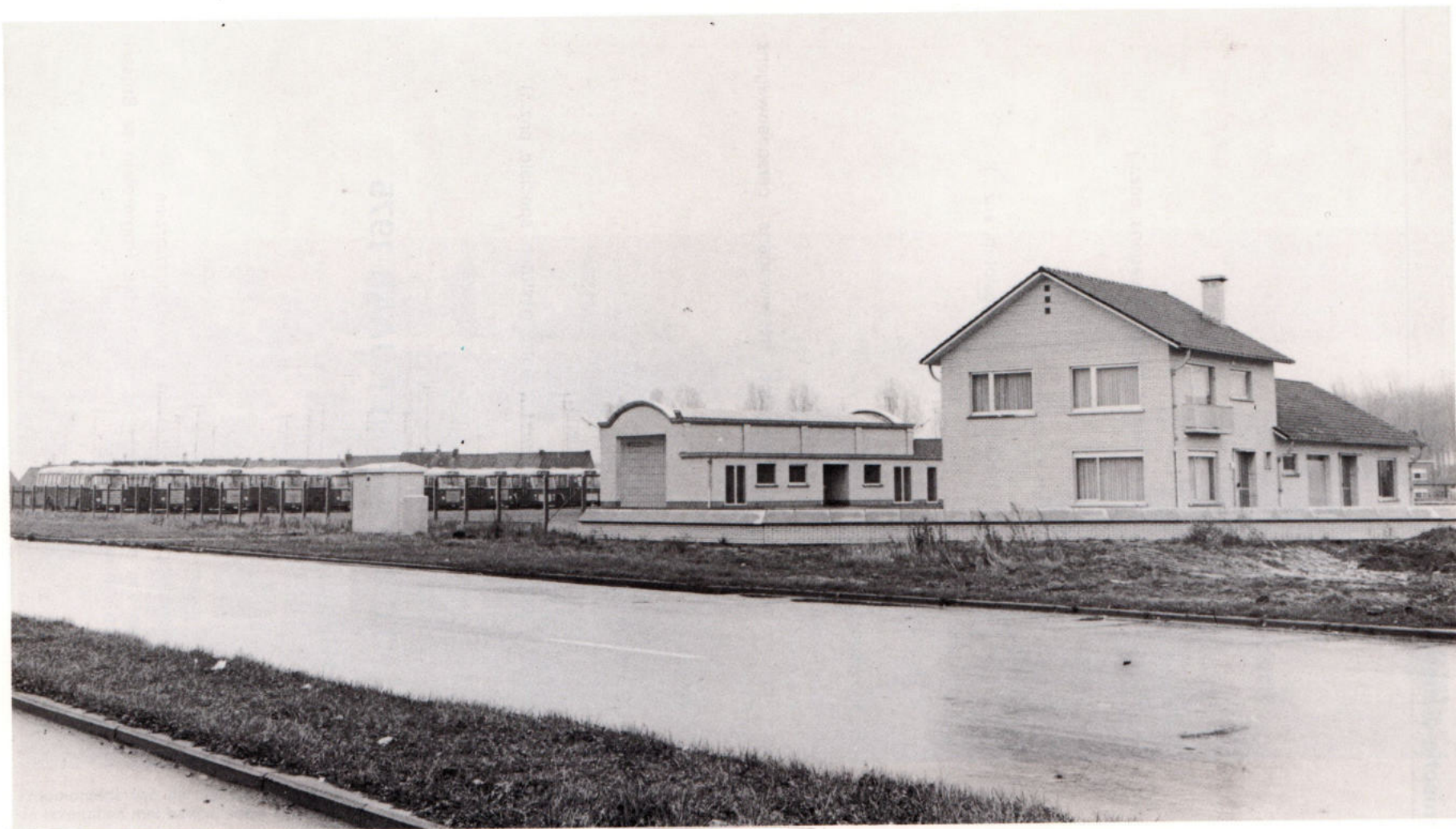
Nieuwe installaties van de stelplaats te Meerbeke, met parkeerruimte voor 30 voertuigen.
