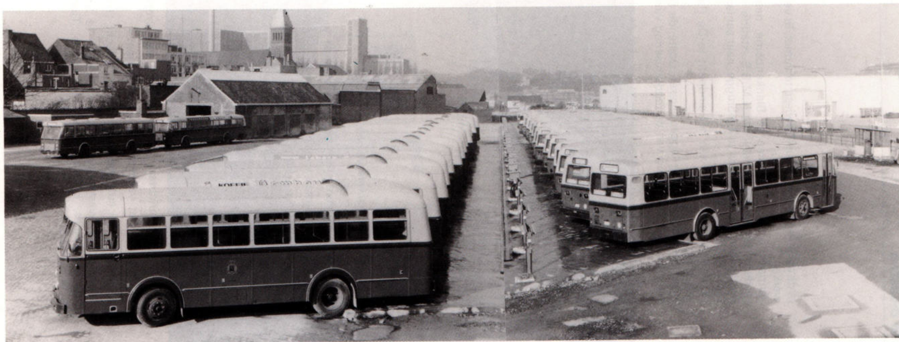
Fotomontage van de nieuwe parkeerruimte voor 58 autobussen in de stelplaats te Leuven. Men ziet de kolommen met batterijladers waardoor de voertuigen bij grote koude vóórverwarmd kunnen worden.
