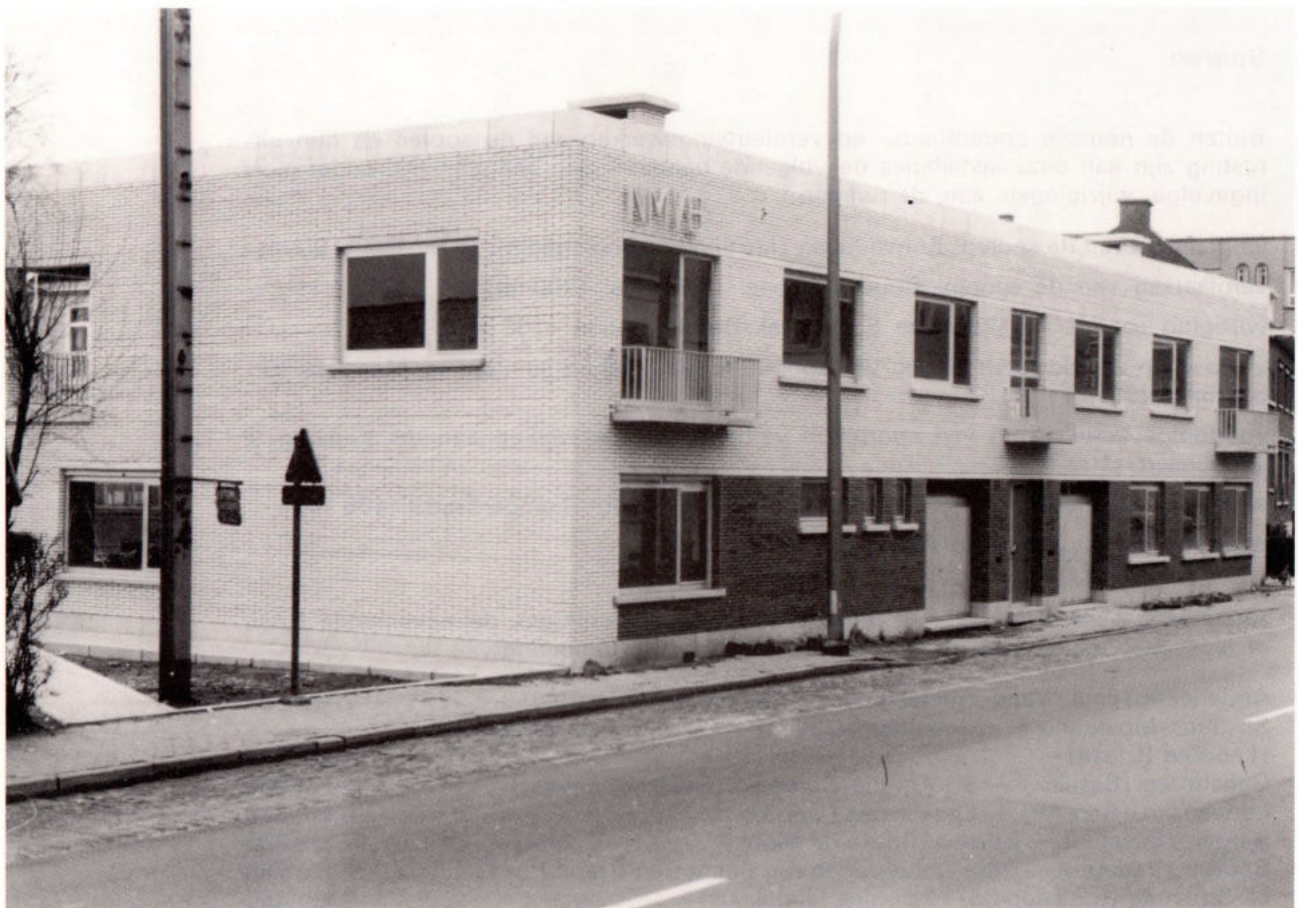
Nieuw gebouw te Oostende, Nieuwpoortsteenweg, dat sociale installaties en twee appartementen omvat.
