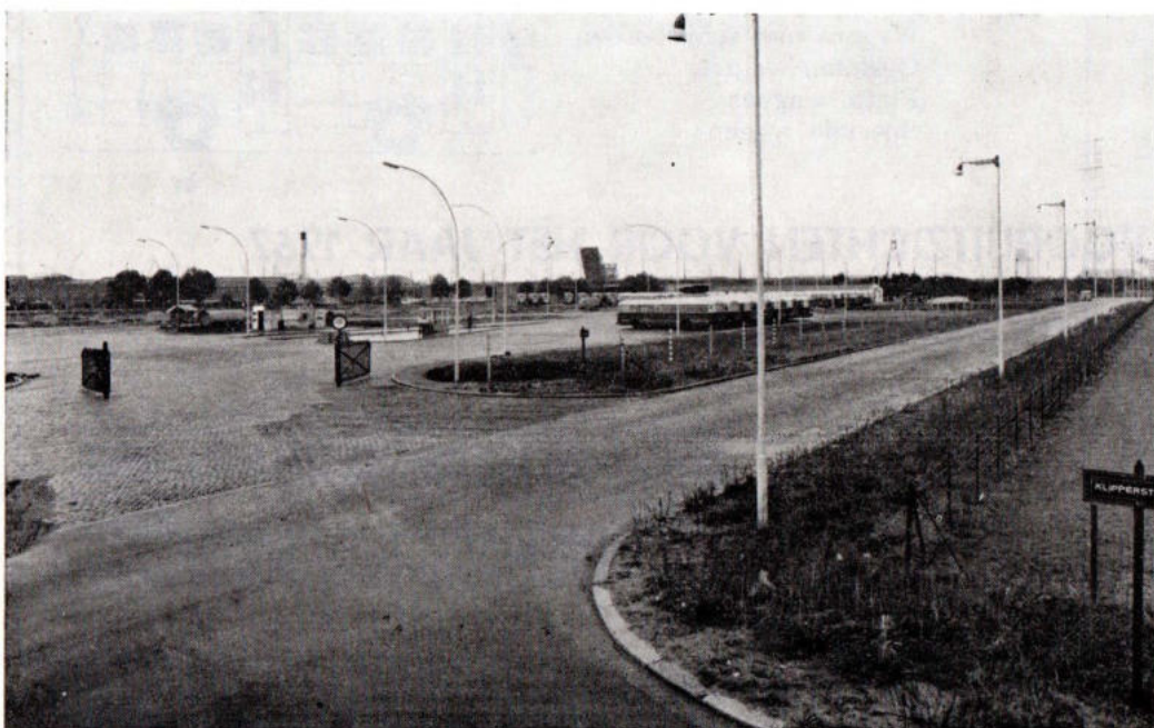
Fig. 10. Parkeerterrein van de in aanbouw zijnde stelplaats te Antwerpen (Tjalkstraat).
