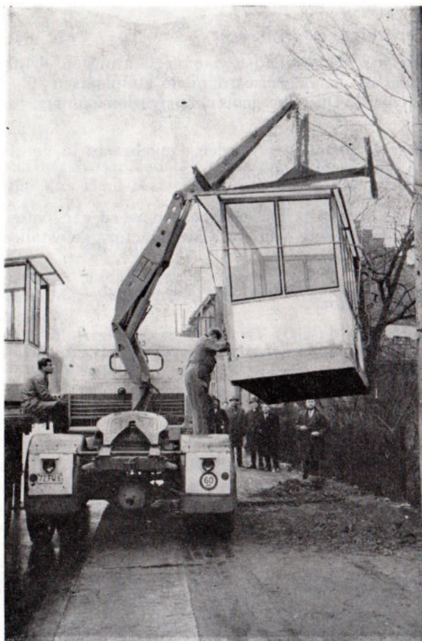
Fig. 10. Plaatsen van een geprefabriceerde schuilplaats voor reizigers.
