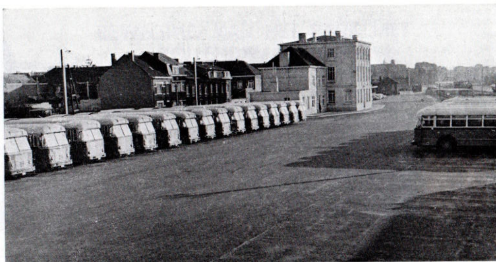
Fig. 9. — Parkeerplaats voor autobussen in de stelplaats te Hasselt.
