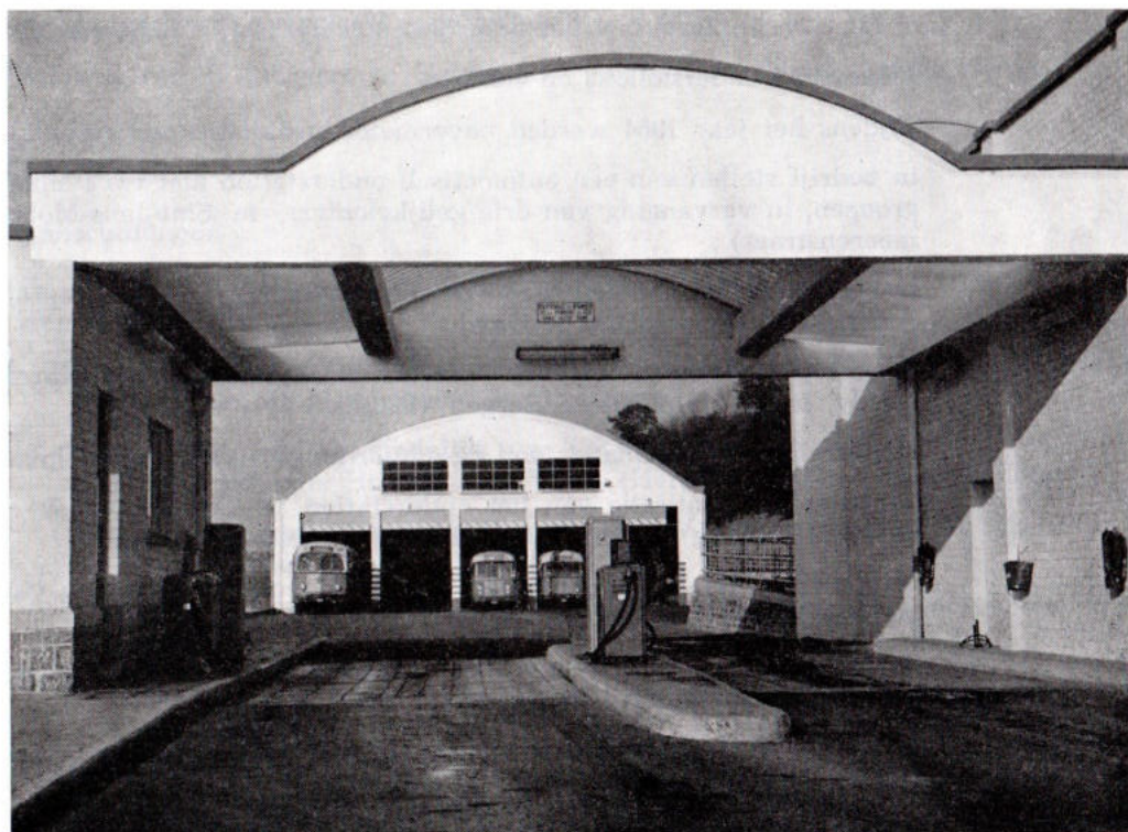
Fig. 7. — Distributietunnel voor brandstof, en garage van de stelplaats te Salzinnes.
