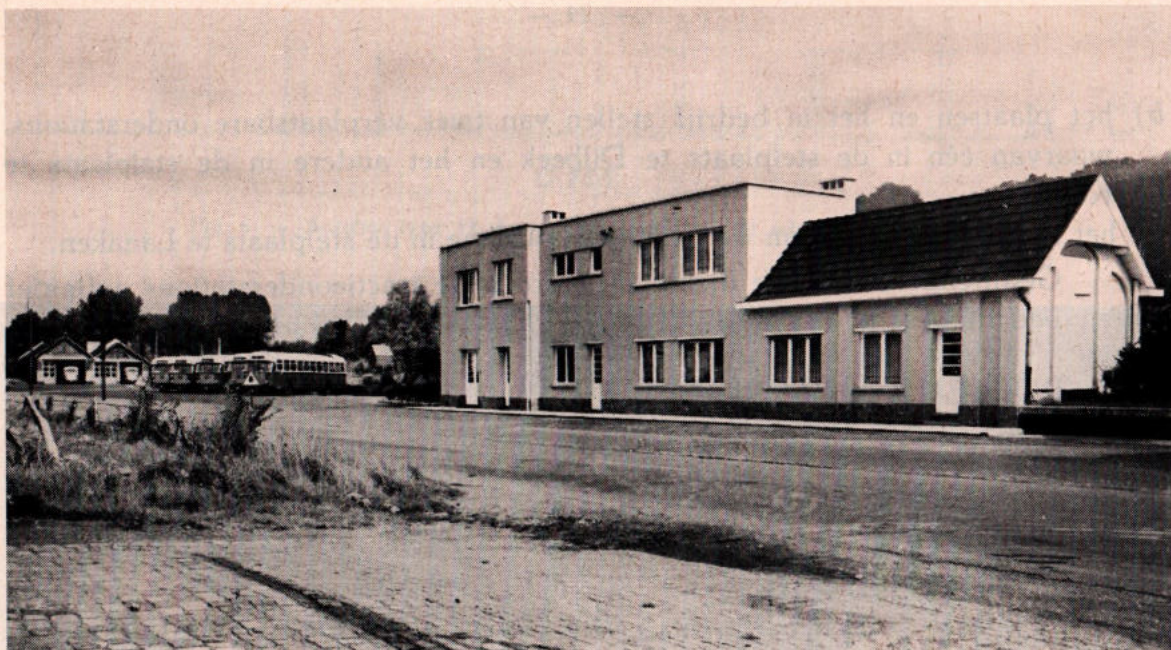
Fig. 4. — Gemoderniseerde stelplaats te Bitsingen.
