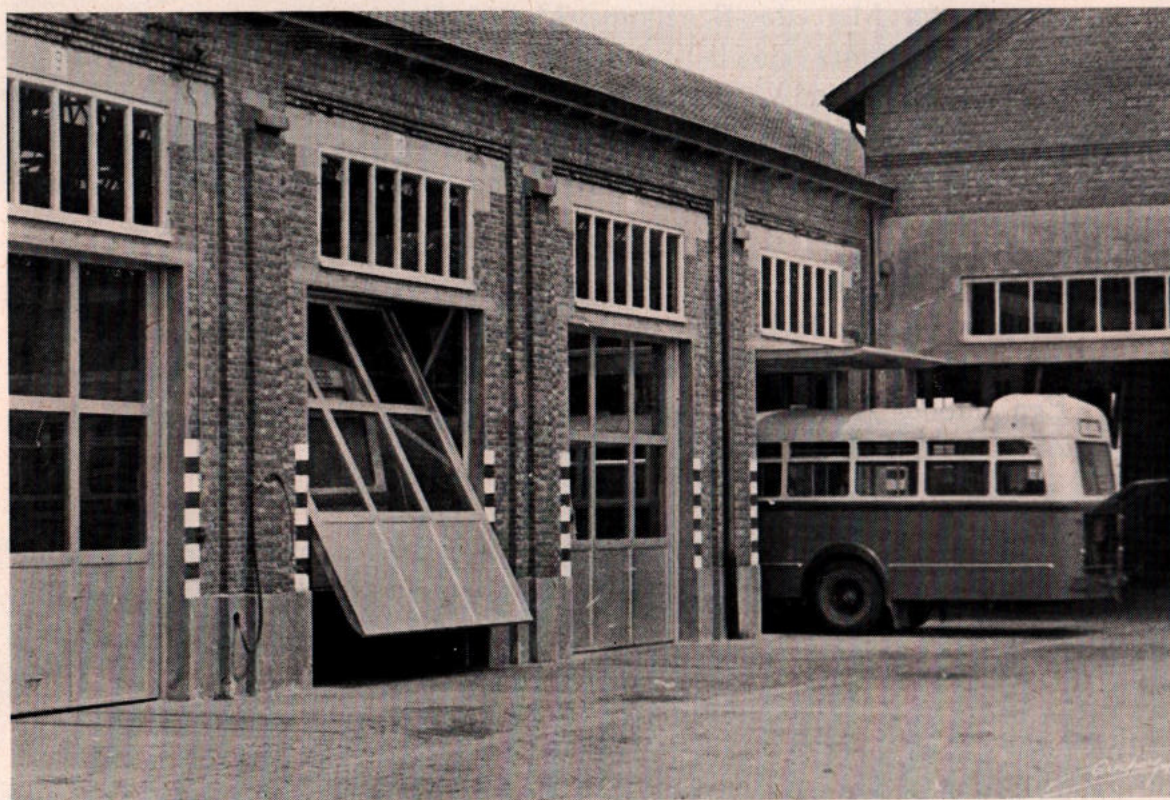
Fig. 5. — Destelbergen. — Ingangen van de werkplaatsen.
