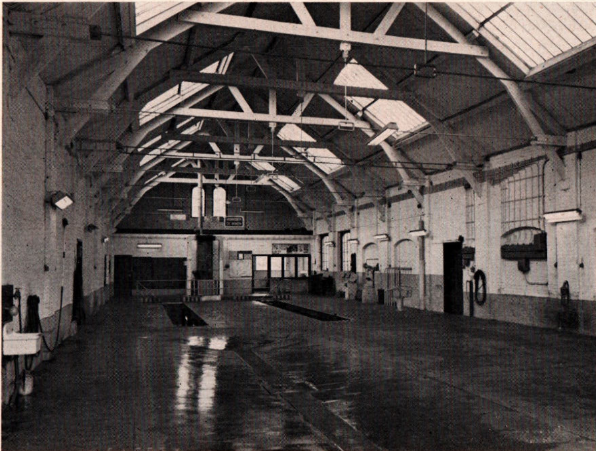
Fig. 9. — Ieper — Binnengezicht van de oude loods, ingericht als garage.
