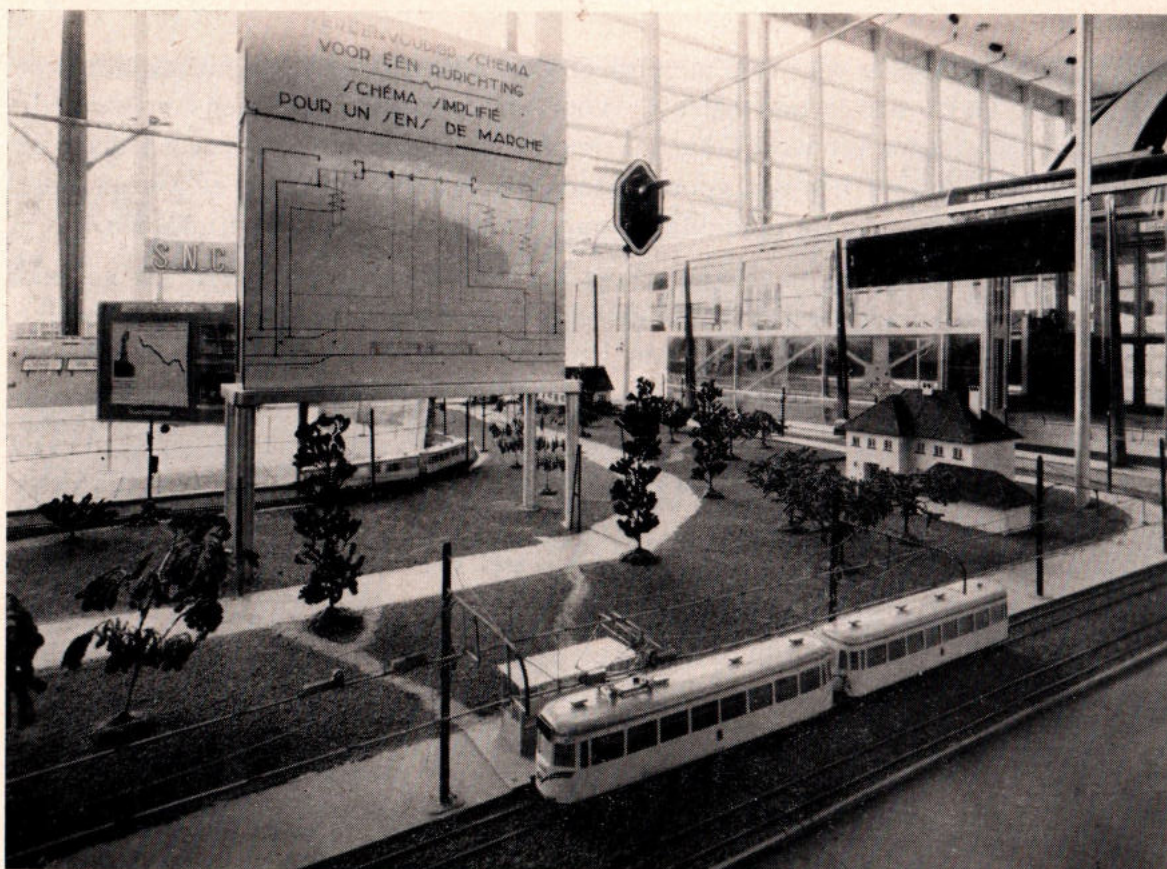
Fig. 23. — Tentoonstelling 1958 — Paviljoen van het Vervoer — Het miniatuurnet, dat de werking toont van de signalisatie van de enkelspoorlijnen en van de onbewaakte overwegen.
