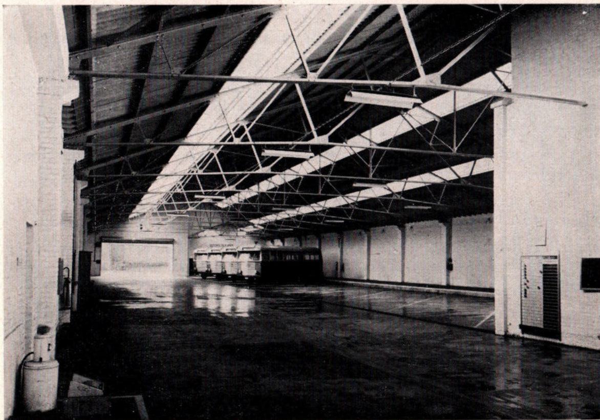
Fig. 17. — La Louvière — Garage voor autobussen.
