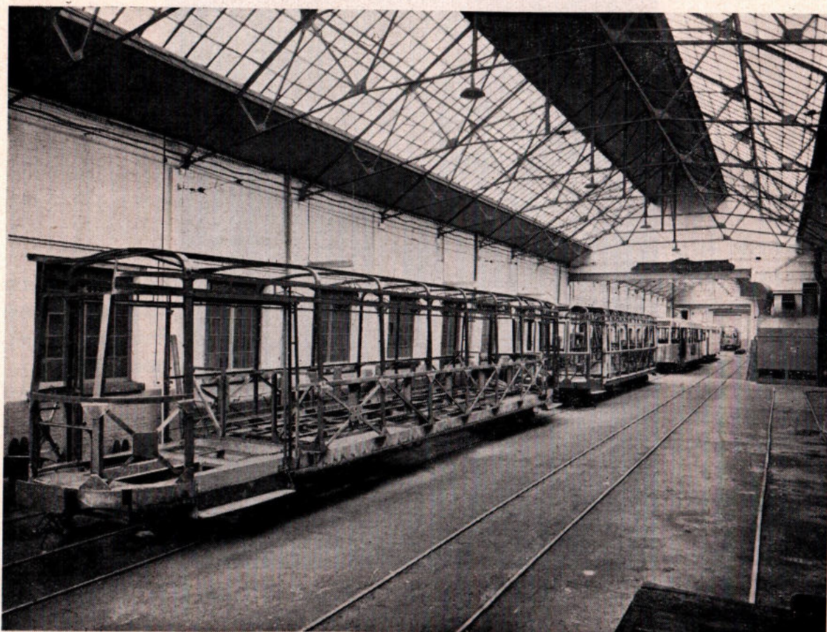
Fig. 7. — Werkplaats te Kuregem — Bouw van de kas voor electrisch rijtuig.
