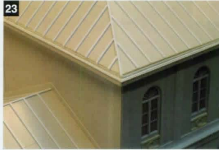
23 Detail van de dakgoot.
