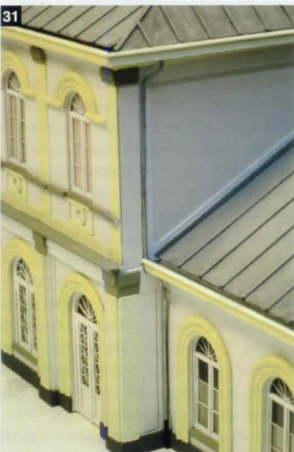
31 Detail van de regenafvoerpijpen.
