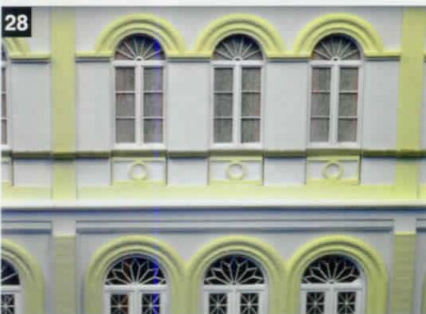
28 Detail van de raamdorpels die doorgetrokken zijn over de gehele gevel.
