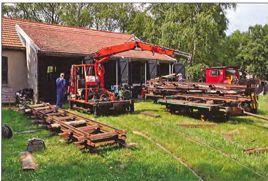
Werkzaamheden bij de oude historische remise
