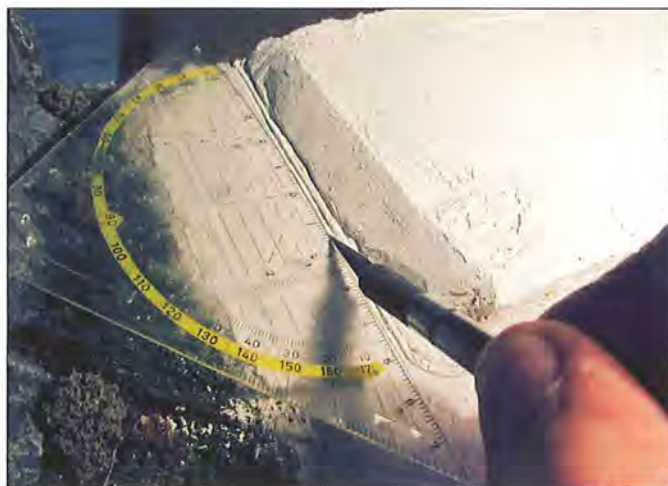
We trekken de groeven voor de boordstenen en de goot.
