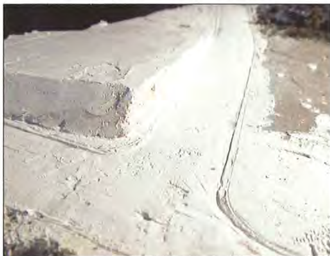
De kasseiweg in wording krijgt vorm, en vertoont duidelijk een licht bollend profiel.
