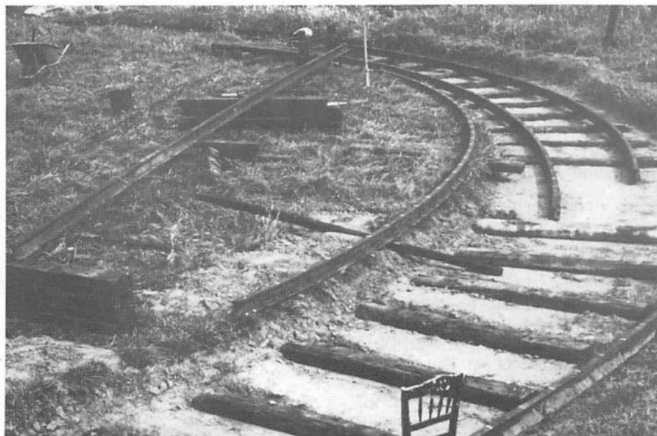
Een algemeen zicht op het aanleggen van de cirkelvormige trambaan te St.-Amandsberg.
