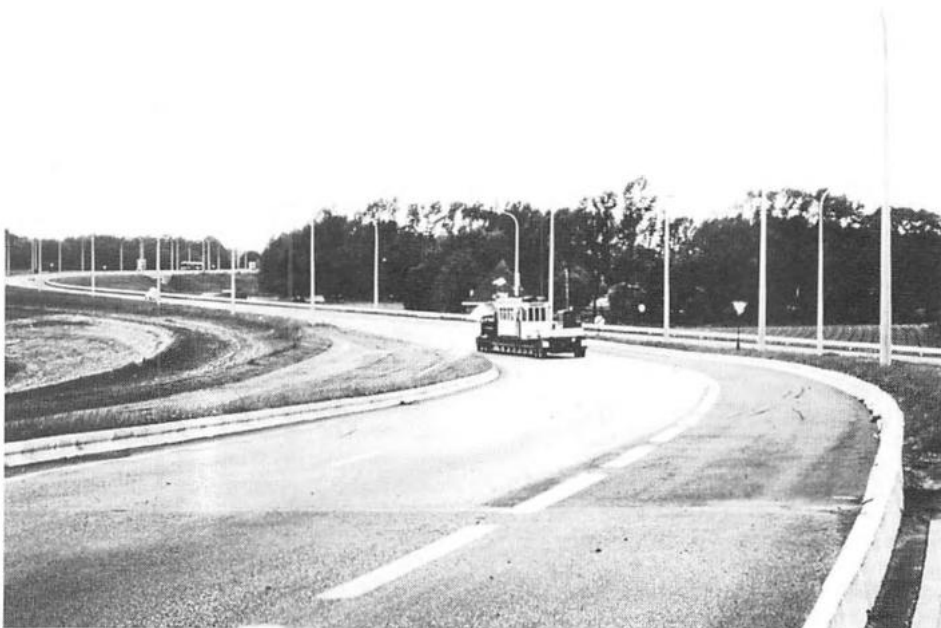
De 354 op de verkeerswisselaar te Destelbergen richting St.-Amandsberg.
