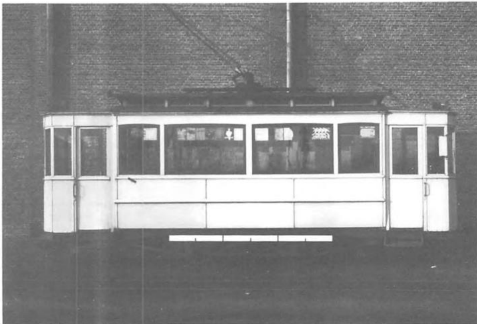
Motorrijtuig van de reeks 174 - 179 (1913). Na ombouw geen ploideurtjes zoals de andere twee-assers. (Archief M.I.V.G.)
