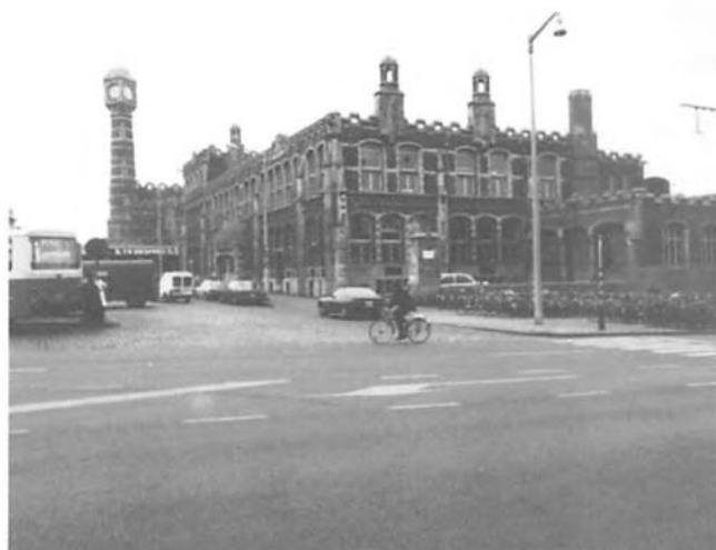
De bouw van een tramstation en een gelijkgrondse doorsteek onder de spoorwegberm van het Sint-Pietersstation kreeg de goedkeuring van de Minister van Verkeerswezen op 15 februari 1985.
