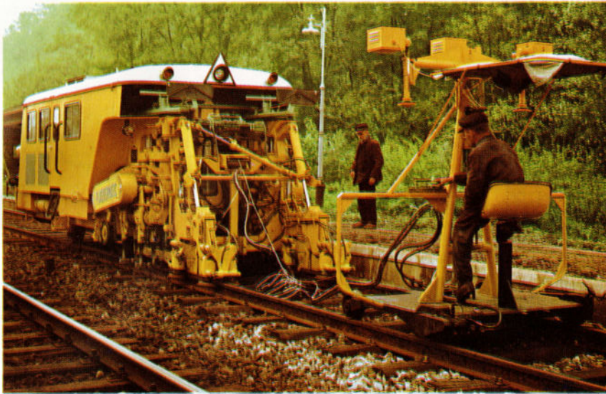
Mécanisation des travaux de voie.
