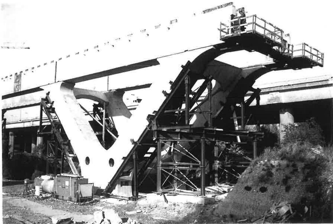
Les quatre viaducs, dits de José (420 m, partiellement en courbe), de Herve (470 m), de Battice (de loin le plus long avec ses 1230 m au dessus de l'échangeur autoroutier) et de Ruyf (le plus modeste avec ses 312 m) sont constitués d'une série de portiques à béquilles inclinées supportant des tabliers (isostatiques, petite précision pour les familiers de la stabilité des
