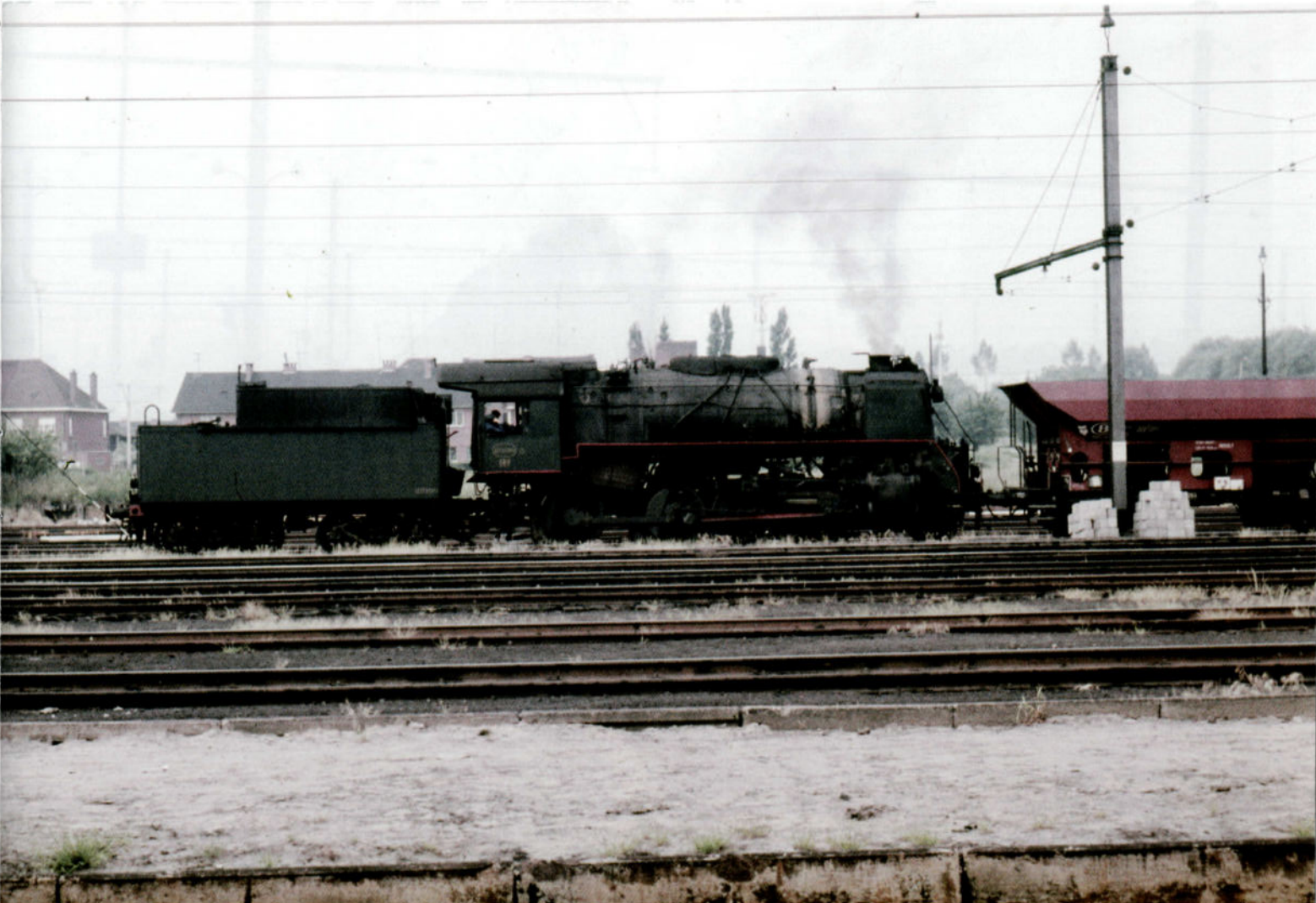
PHOTO 136-50 En 1966, c'est à Aalst que l'on trouvait le plus grand nombre de locomotives à vapeur en service. Lors de l'application du service d'hiver le 3 octobre 1966, les types 29 avaient encore un roulement de 10 jours. Il fut toutefois ramené à six jours le 5 décembre et supprimé définitivement le 20 décembre. Cette photo montre la 29.199 manoeuvrant des wagons à Aalst. Nous avons déjà vu une photographie de cette machine lors de ses derniers jours à Ronet page 45, juste avant sa mutation à Merelbeke. Photo Hugo NAUWELAERTS, collection PFT.
