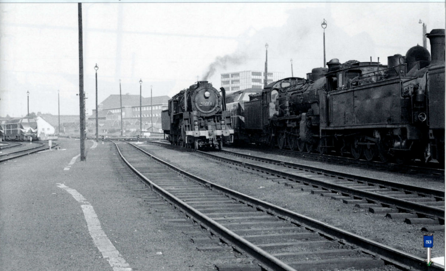
PHOTO 136-51 Le 10 septembre 1966, la même locomotive se trouvait en escale à Kortrijk. A droite, des types 64 et 53 sont définitivement éteintes. Photo Hugo NAUWELAERTS, collection PFT.
