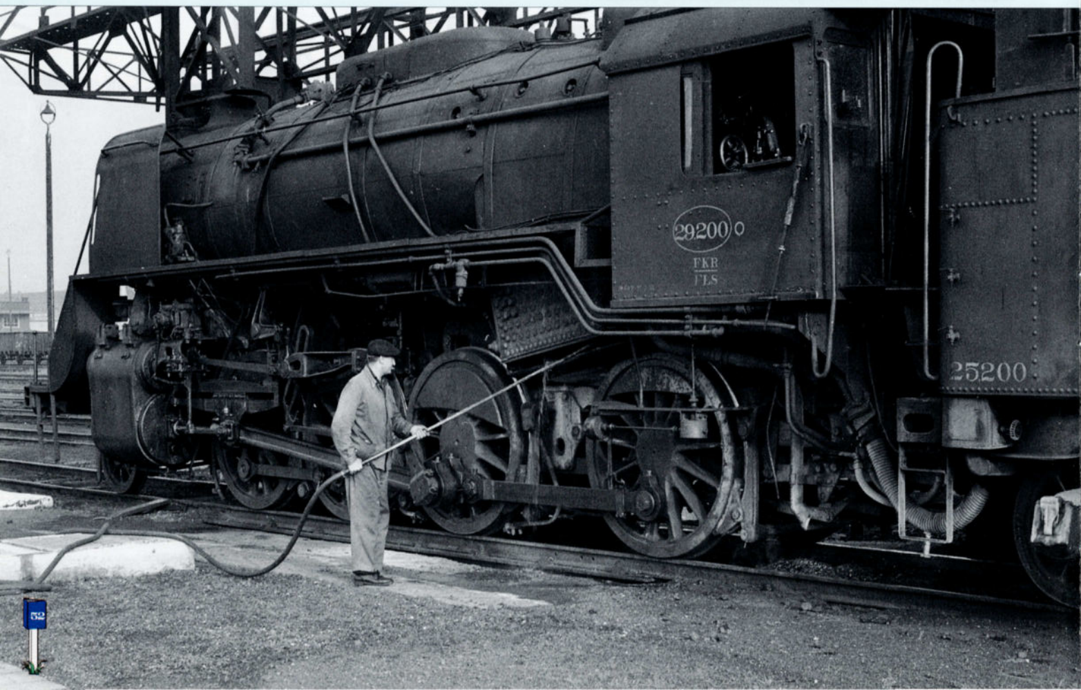
PHOTO 136-48 ↑ - PHOTO 136-49 ↓ Le 10 septembre 1966 à Kortrijk, la 29.200 de la remise d'Aalst se prépare pour le voyage du retour : prise d'eau et nettoyage de la grille du foyer. Tout un monde qui n'avait plus que pour quelques semaines à vivre. Cette type 29, construite par Canadian Locomotive Company (n° 2327), débuta sa carrière au dépôt d'Ottignies le 20 août 1946. Elle sera par la suite mutée aux remises de Kortrijk (12 juin 1957), Ronet (27 février 1958), Bertrix (24 novembre 1958), Latour (27 septembre 1963), Ronet (15 janvier 1965) et enfin Merelbeke (2 février 1966) où elle acheva sa carrière à l'annexe d'Aalst. Considérée comme réserve réseau, elle fut mutée le 6 février 1967 à Leuven et fut réformée le 20 avril 1967. Photos Hugo NAUWELAERTS, collection PFT.
