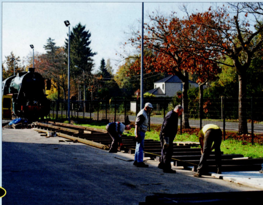
Travaux de prolongation de la voie, patronnés par l'équipe du Bocq. PFT.
