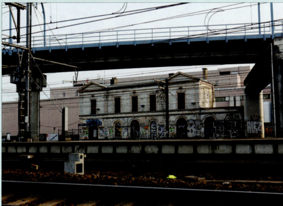
PHOTO 131-23 La gare de Forest-Midi telle qu'elle se présente aujourd'hui, très délabrée et enclavée entre la ligne 96, le viaduc de la ligne 96A et l'usine Audi. Pas vraiment un endroit idyllique pour une gare classée... 17 décembre 2015.
