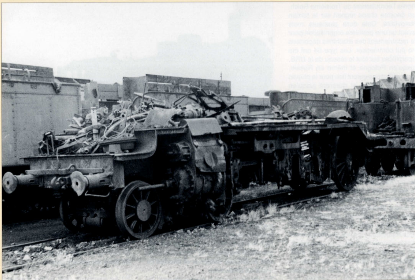
Les 6416 et 6500 revenues en très mauvais état furent démolies en 1950. Cette photo, prise à l'Atelier Central de Salzinnes le 28 juin 1950, montre une des deux machines. Photo Bruno DEDONCKER, collection PFT.
