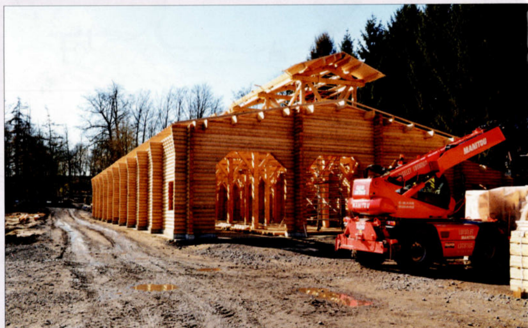
PHOTO 127-51 ↑ - PHOTO 127-52 ↓ La magnifique remise qui comporte trois voies a été entièrement construite en bois. Pierre HERBIET.
