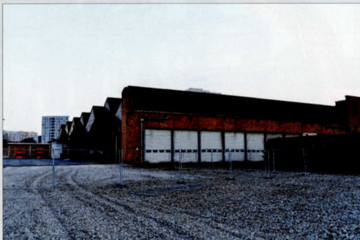
PHOTO 127-40 La remise de Leuven s'est vue amputée de la moitié de son bâtiment. Après l'enlèvement des voies en 2014, la partie gauche a été démolie fin 2014-début 2015.
