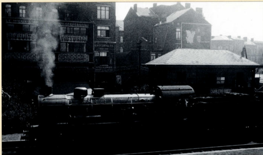
La 6544 fut gravement endommagée en Allemagne. Elle fut démolie après son retour en Belgique. Le 7 août 1933, elle s'apprête à quitter la gare de Charleroi-Ouest avec l'omnibus 699 à destination d'Ottignies. A ce moment, elle était affectée à la remise d'Ottignies. Photo : J. QUANJER, collection Maurice HENNEQUIN / PFT.
