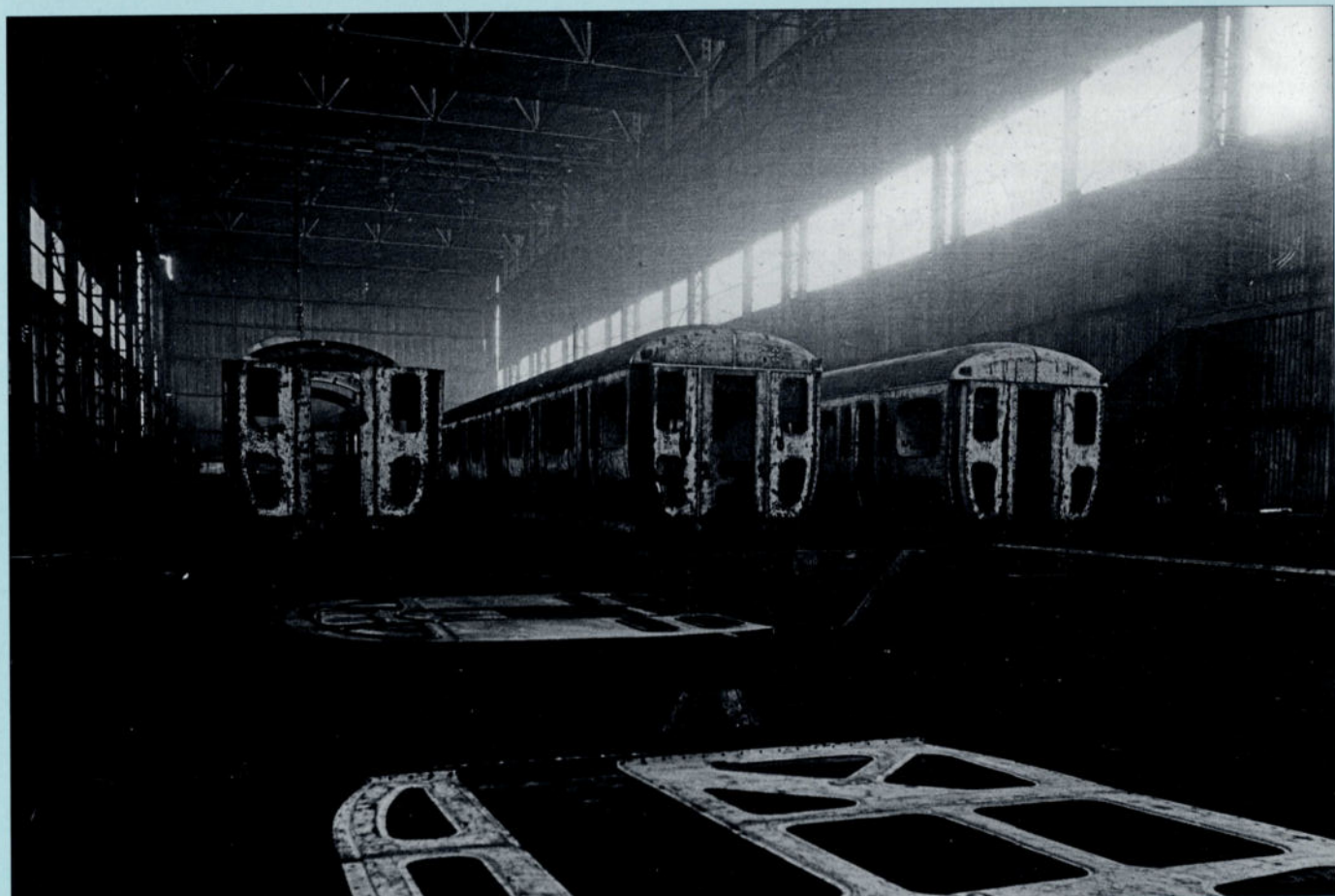
Construction des voitures de 3e classe de la série 15 à 20 du Nord-Belge dans l'usine de Baume & Marpent.
