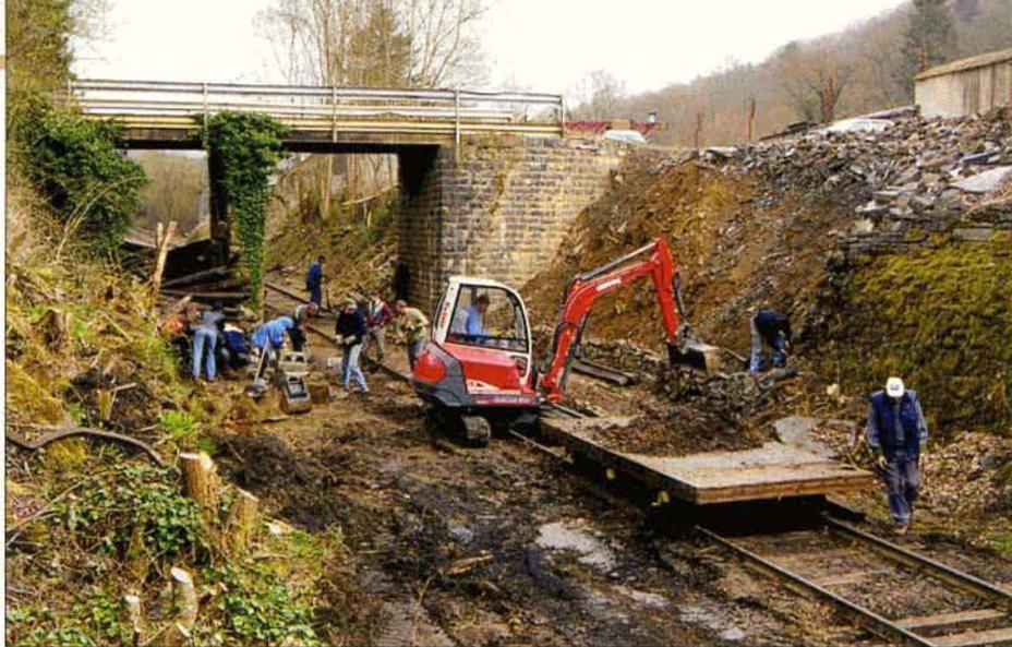
**Le 16 avril 2000, l'équipe du Bocq travaillait à l'entrée de la gare de Dorinne-Durnal. Le talus devait être consolidé, la voie débarrassée des coulées de boue, des caniveaux placés pour l'évacuation des eaux.**
