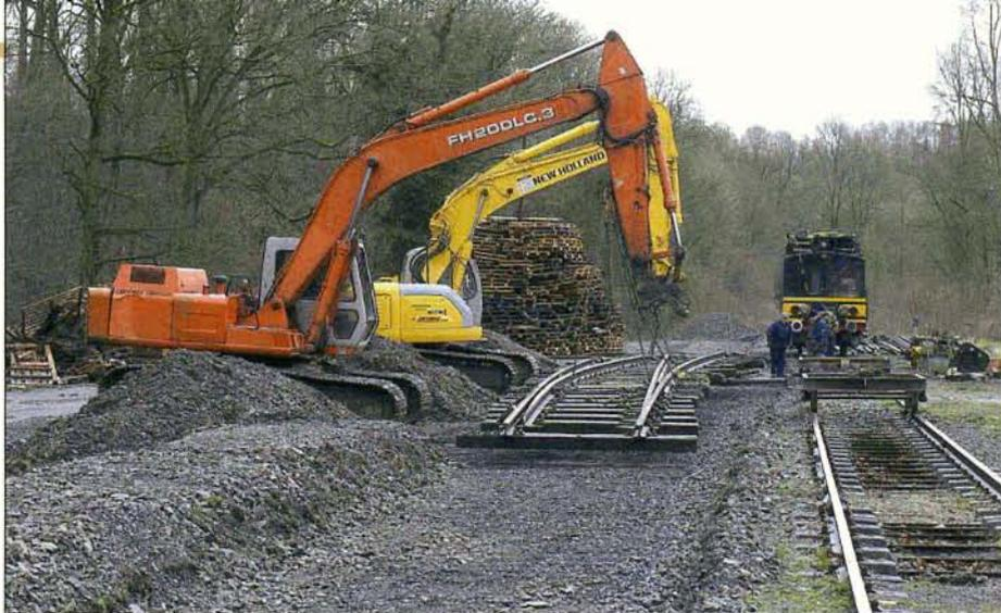
*Ci-dessus : le 3 mars 2007, travaux lourds à Spontin, pour la pose de deux aiguillages en vue de remettre une voie d'évitement en service. Ci-dessous : pose de la nouvelle voie à proximité de la gare de Purnode. PFT.*
