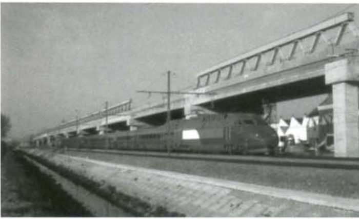
Le viaduc de Lot permettra aux voies TGV de s'insérer entre celles de la 96. Les rambardes métalliques seront peintes en orange. Le TGV 86 Bruxelles-Paris circule sur la future voie B de la ligne 96 et longe le viaduc. Lot, 15 avril 1996.
