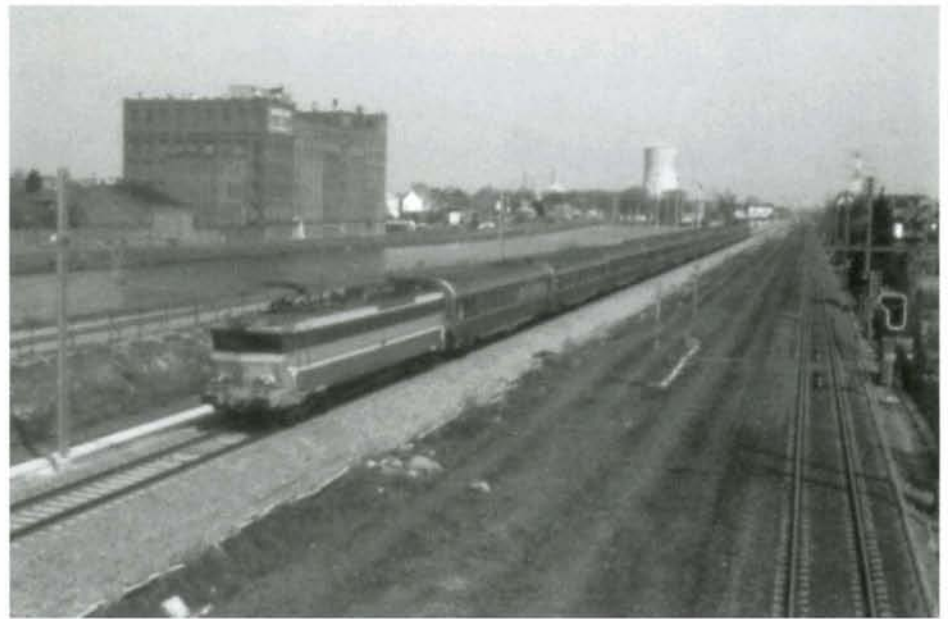
Entre Lot et Ruisbroek, les deux voies de la ligne 96 sont posées définitivement. L'espace médian sera utilisé pour la pose des voies TGV. Le train EC 82 Amsterdam-Paris circule à contre-voie vers Halle. Ruisbroek, 20 avril 1996. Photo : Christian DOSOGNE.
