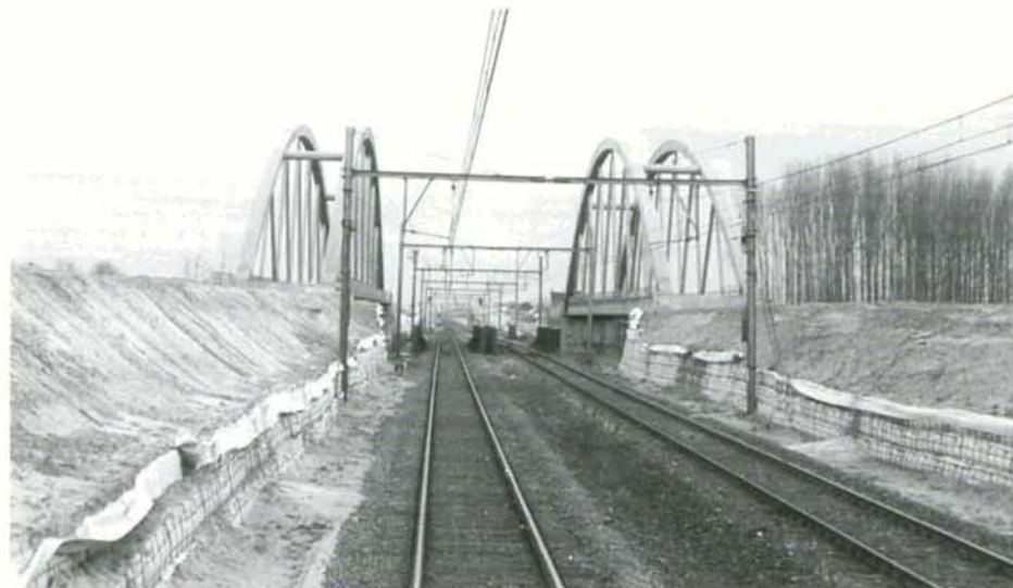
Les importants travaux en cours depuis 1994 à Landegem (ligne 50 Gent-Brugge) (voir EN LIGNES 19) se poursuivent, avec l'établissement des nouvelles assiettes devant permettre d'accéder aux nouveaux ponts franchissant le canal de Schipdonk. Ce document montre les rampes d'accès telles qu'elles se présentaient le 2 mars 1996.
