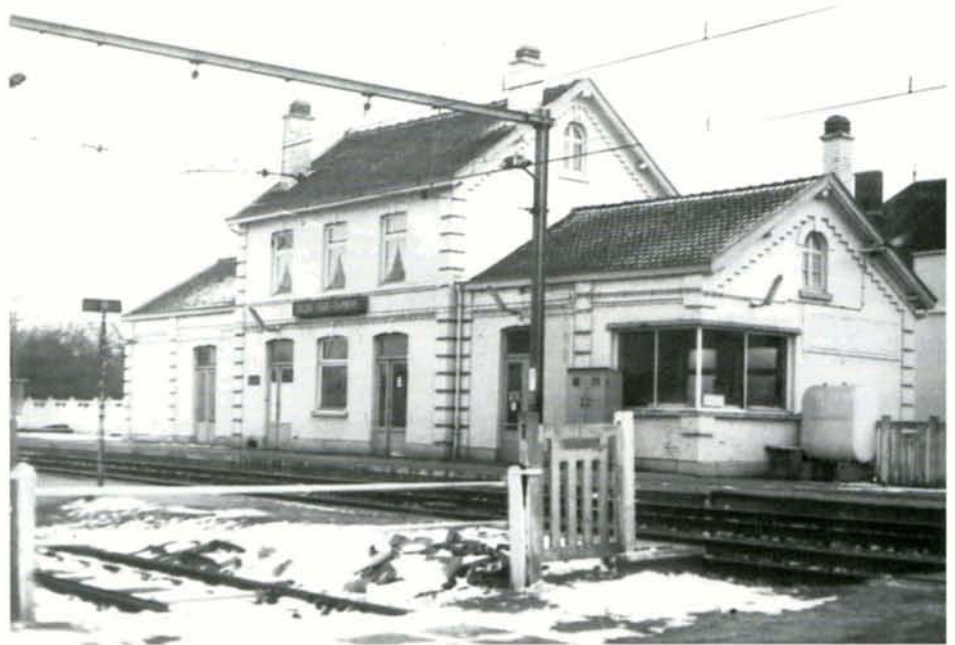
Située sur la ligne 130A Charleroi-Erquennes, la gare de Solre-sur-Sambre a été démolie dans le courant du mois de mars dernier. 9 février 1978. Photo : DIEU.
