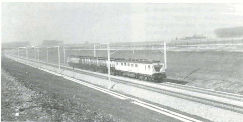
PHOTO 26-27 Divers trains de finition ont travaillé sur la ligne nouvelle. Le train-meuleur Spéno opère à la BK80. Rumes, 11 mars 1996. Photos : Baudouin DIEU.
