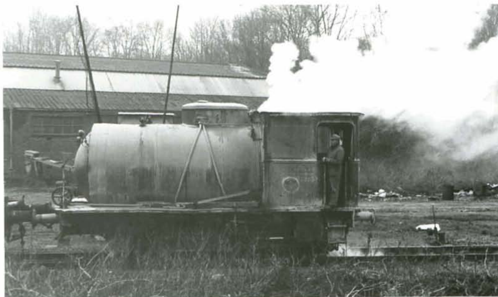
La toute dernière locomotive à vapeur de Belgique : la 020 T sans foyer de la firme "Produits Chimiques du Marly". Janvier 1979. Photo : Pierre HERBIET.
