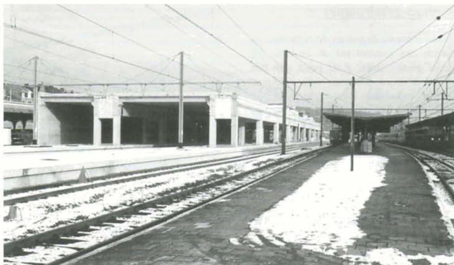
Très lentement, la première partie de la nouvelle gare de Namur prend forme. Ce document montre l'état d'avancement des travaux le 29 janvier dernier. A. DEFECHEREUX.
