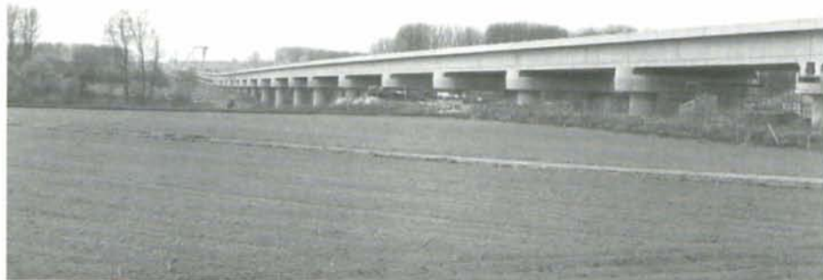
PHOTO 26-29 Le viaduc d'Arbre photographié vers la France. Vingt-neuf travées sont terminées ou presque; sa longueur sera de plus de deux kilomètres. Arbre, 17 avril 1996.
