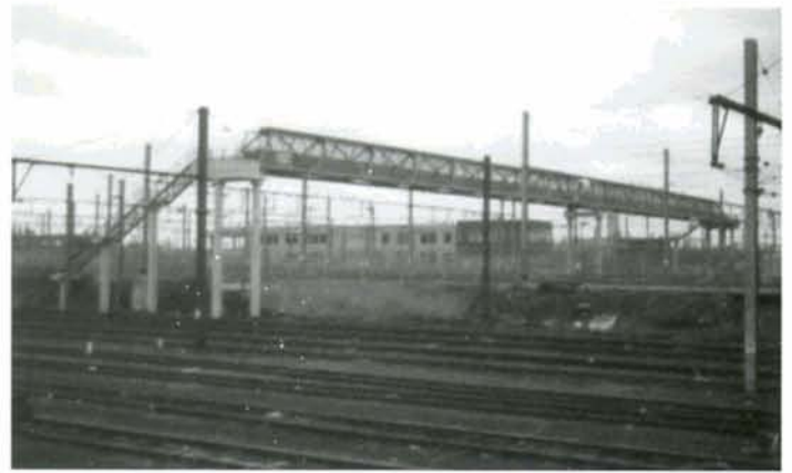
La passerelle qui permet d'enjamber la "zone stérile" de l'atelier TGV de Forest est installée. Il est ainsi possible de passer à pied d'un faisceau à l'autre. Forest, 17 février 1996. Photos : Christian DOSOGNE.
