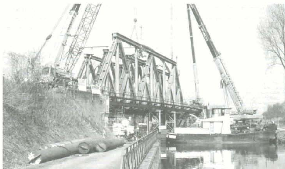
Le 9 mars, deux grues géantes déposaient le pont métallique qui permettait aux voies de la ligne 96 de franchir le canal Bruxelles-Charleroi à l'entrée de Halle côté Mons. Cet ouvrage sera remplacé par un viaduc à arche unique sur lequel passeront les deux voies TGV. Photo: Roger CRICHELAIRES.
