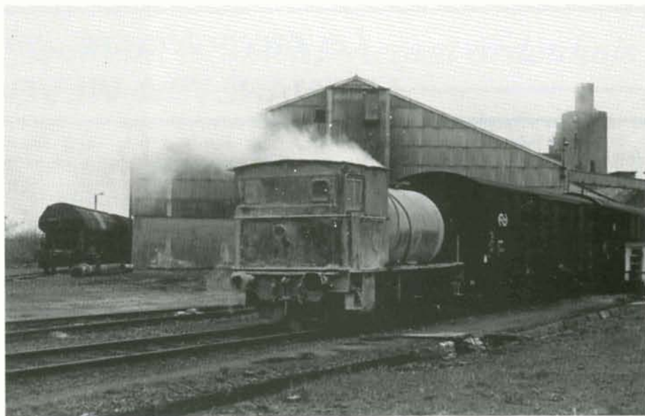
La machine sans foyer à l'action dans l'enceinte de l'usine. On remarquera la cabine de conduite entièrement fermée, probablement pour la protection du personnel lors du chargement des wagons, comme en témoignent les nombreuses salissures blanchâtres.
