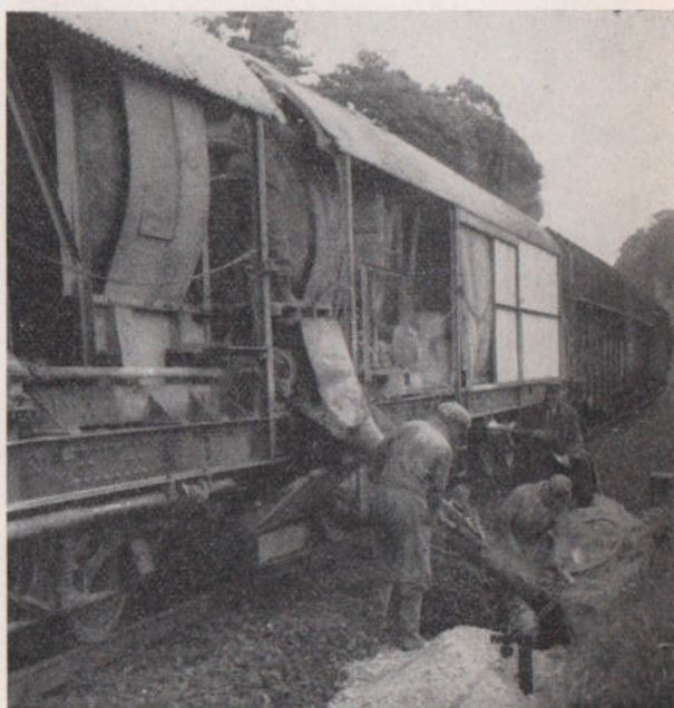
Fig. 17. — Train bétonneur : exécution d'une fondation.
