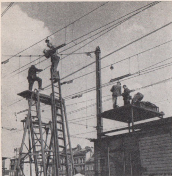
Fig. 24. — Placement d'isolateurs de section.
