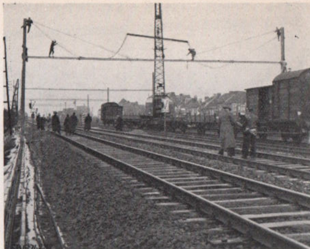
Fig. 19. — Levage d'un portique (6 voies).
