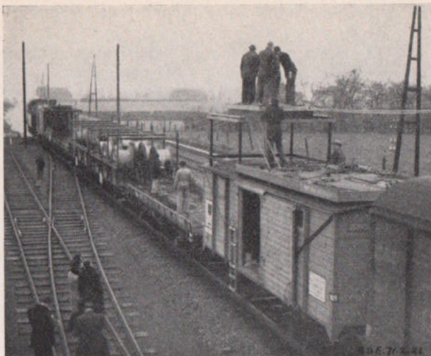
Fig. 21. — Déroulage des fils et câbles.
