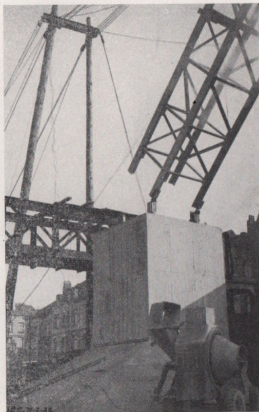
Fig. 26. — Bruxelles-Midi : levage d'un pylône en treillis.
