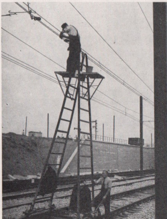
Fig. 22. — Pendulage de la caténaire.
