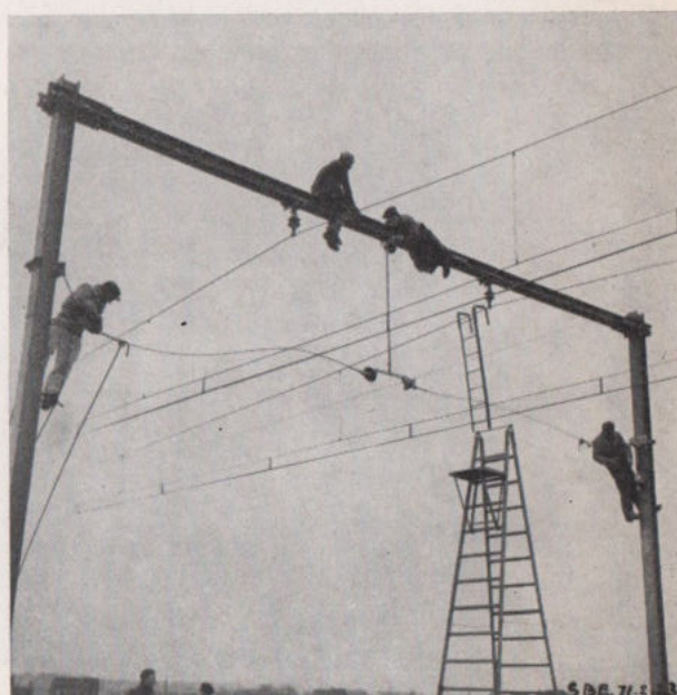
Fig. 23. — Fixation du câble transversal.
