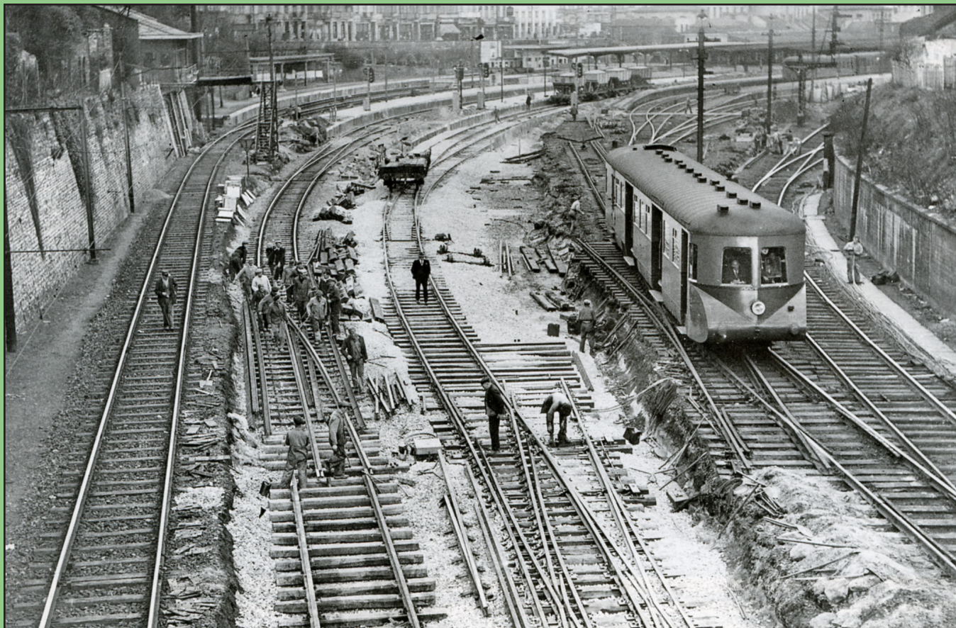
Een motorwagen type 608 rijdt het station van Brussel-Leopoldswijk uit. Grootscheepse werken vormen de aanloop voor een eerste modernisering.
