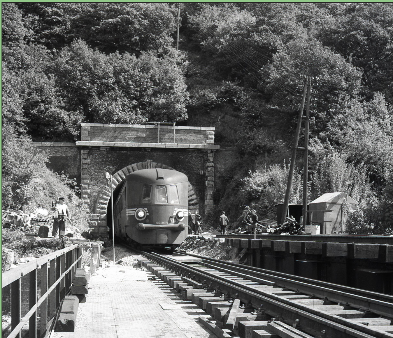
Toen men de lijn 132 verplaatste tussen Walcourt en Senzeilles, waren er ook diverse werken gepland ten noorden van Walcourt. De 620.08 komt -hier - op tegenspoor - uit de tunnel van Ham-sur-Heure gereden op het ogenblik dat het andere spoor verhoogd en vernieuwd werd.
