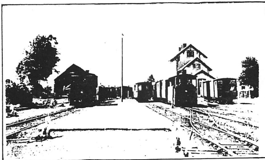
GARE DE FORVILLE
