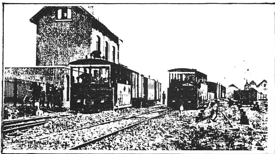
GARE DE FORVILLE
