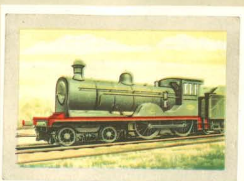
Année de construction : 1908. Bouwjaar : 1908. Type 18bis et 20 - Etat-Belge. Type 18bis en 20 - Belgische Staat.
