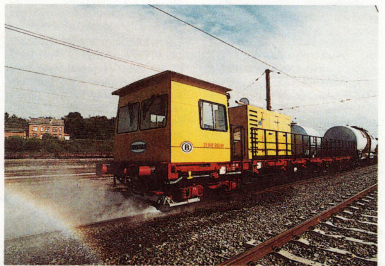
Sous l'arc-en-ciel généré par l'eau projetée par l'engin, le rail est nettoyé.
