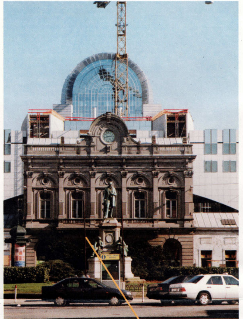
Quartier en rénovation Place du Luxembourg
