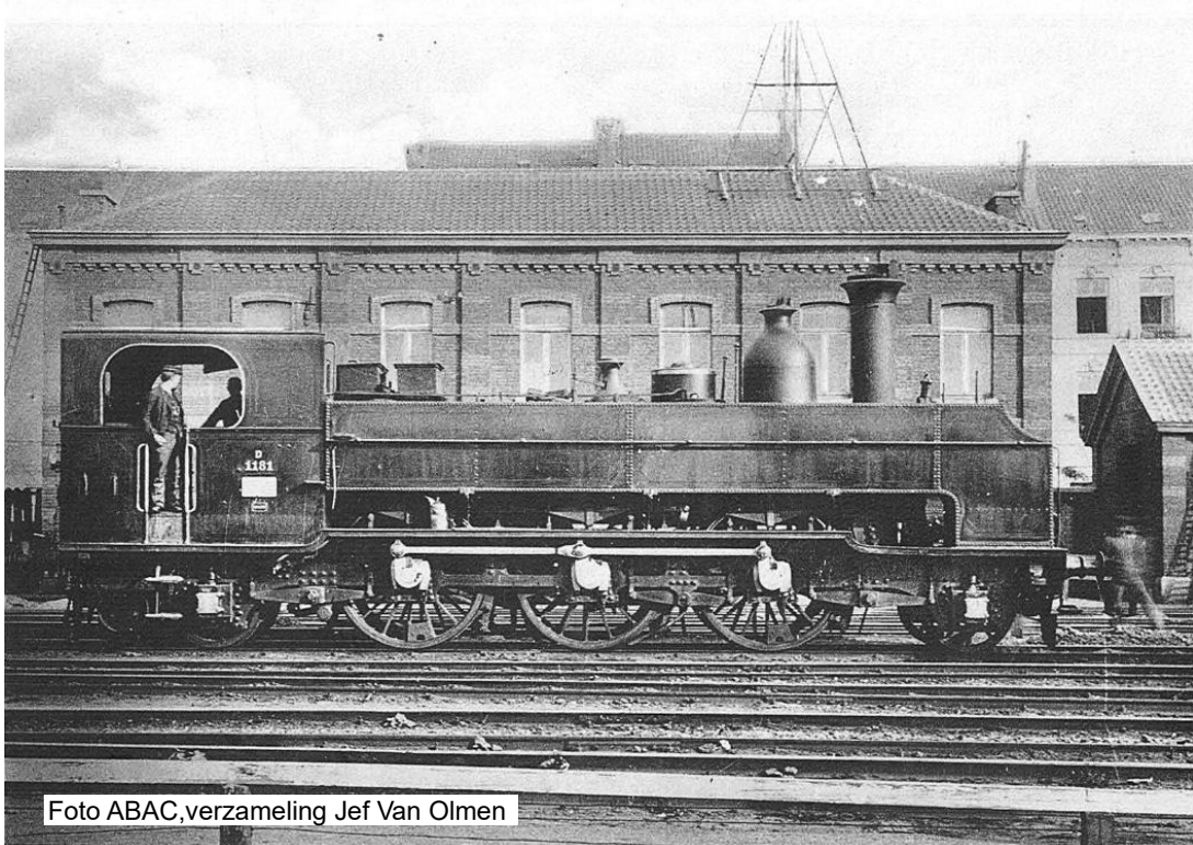
Type 4: tenderlocomotieven voor reizigerstreinen, asindeling 1C1. Gestationeerd in FNSD in 1922 (en wellicht ook vroeger). De foto van loc 1181 werd vóór de Eerste Wereldoorlog genomen op een onbekende locatie. Verzameling ABAC / Jef Van Olmen.
