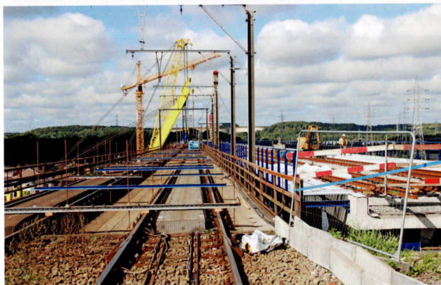
20 août 2017: à gauche, l'ancien tablier au-dessus de la Meuse; à droite, la nouvelle travée 'hyperstatique', posée provisoirement sur l'espace libre des piles, qui étaient surdimensionnées en largeur. Lorsque l'ancien tablier aura été enlevé, cette nouvelle travée sera ripée vers la gauche, à l'emplacement de l'ancien pont. Photo: Jean Renard.
