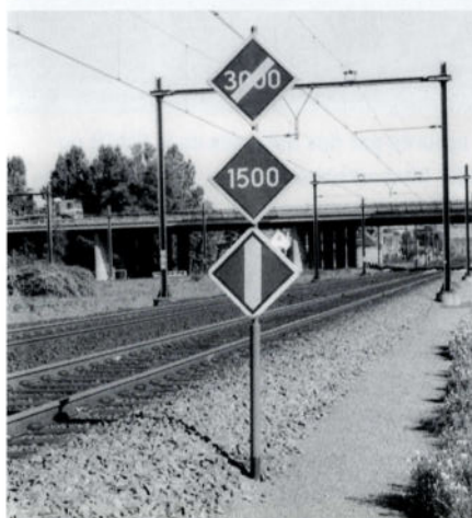
Après franchissement de l'écluse électrique, ce panneau indique que le conducteur peut relever ses pantographes et qu'il sera désormais alimenté en 1500 V (au lieu de 3000 V).
