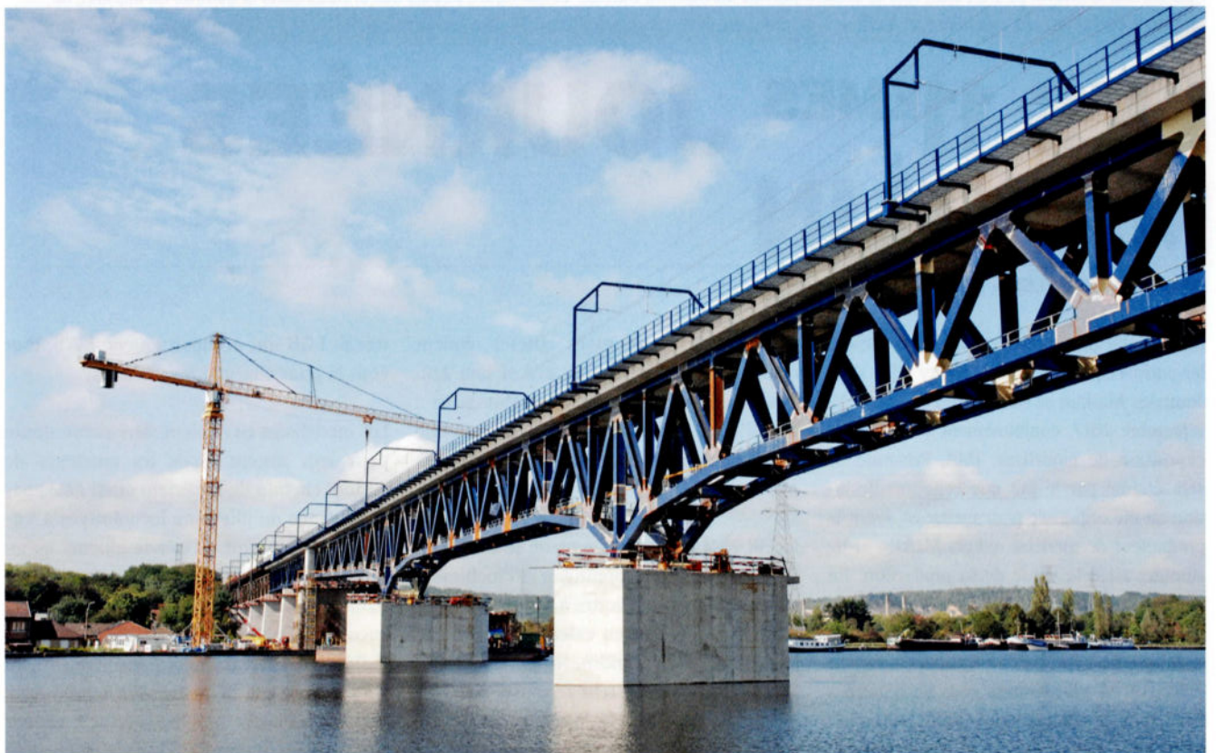
23 septembre 2017: la nouvelle travée hyperstatique (de 245 m de long) a été ripée à l'emplacement de l'ancien tablier. Au loin, les anciens tabliers sur la rive gauche (reconnaissables à leur teinte différente) feront également l'objet ultérieurement d'une substitution. Photo: Jean Renard.
