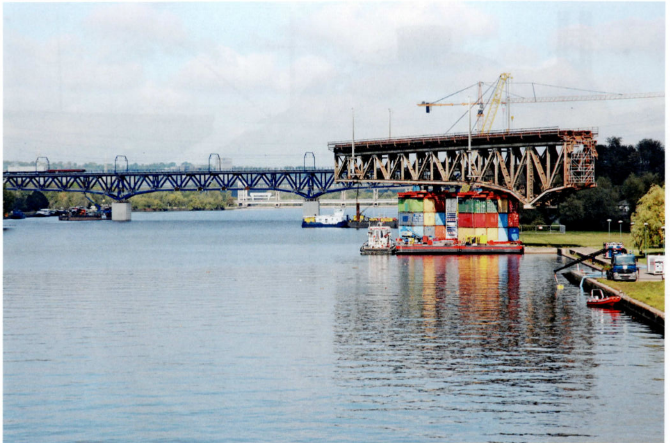
23 septembre 2017: tandis que la longue travée neuve surplombant la Meuse a été ripée à l'endroit de l'ancienne, une partie de cette dernière est évacuée sur la rive droite au moyen d'une barge, des conteneurs empilés faisant office de supports. Sur le pont au loin, on aperçoit un train de pose des caténaires. Photo: Jean Renard.
