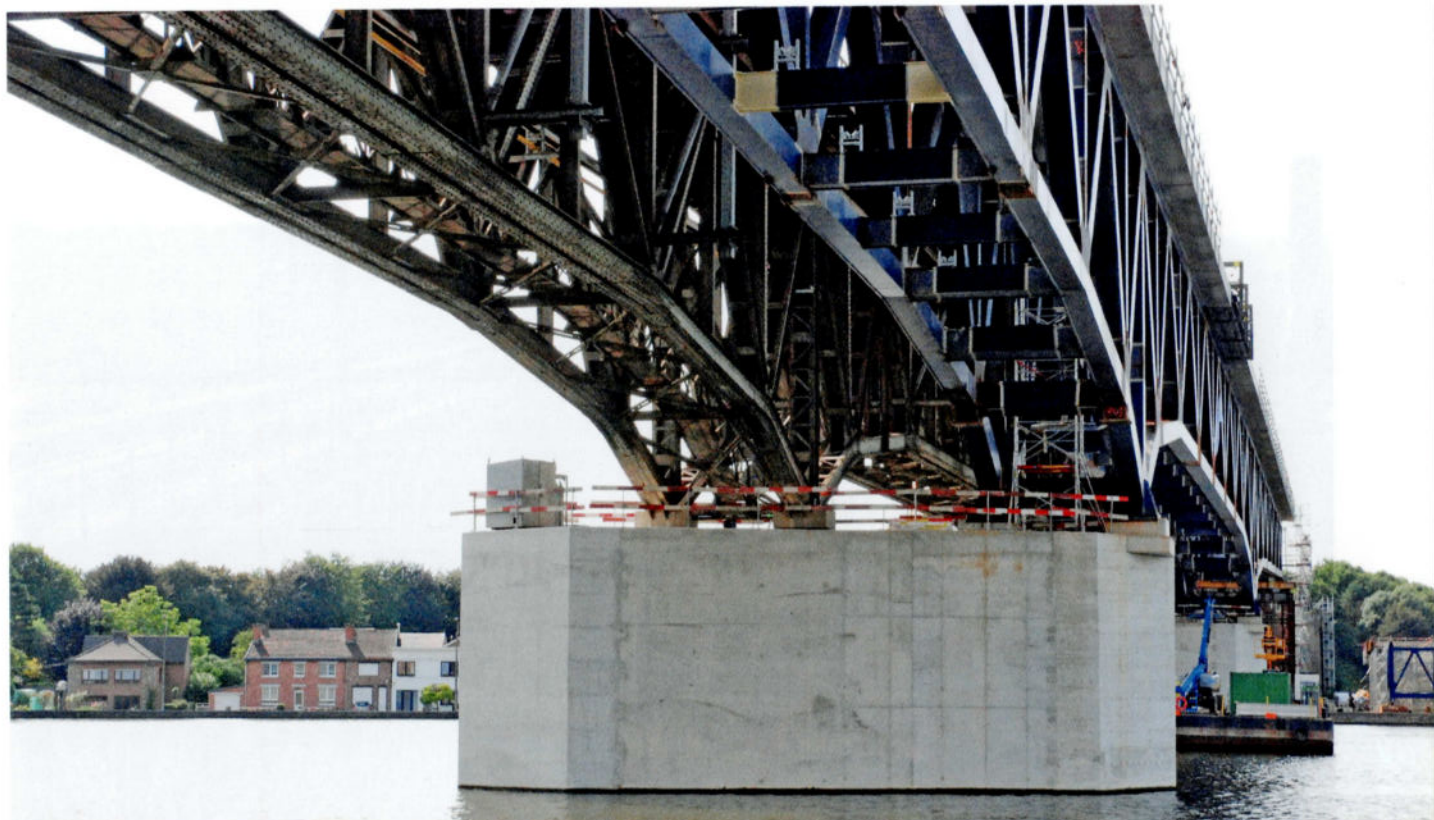
20 août 2017: à gauche, l'ancien tablier au-dessus de la Meuse; à droite, la nouvelle travée 'hyperstatique', posée provisoirement sur l'espace libre des piles, qui étaient surdimensionnées en largeur. Lorsque l'ancien tablier aura été enlevé, cette nouvelle travée sera ripée vers la gauche, à l'emplacement de l'ancien pont. Photo: Jean Renard.
