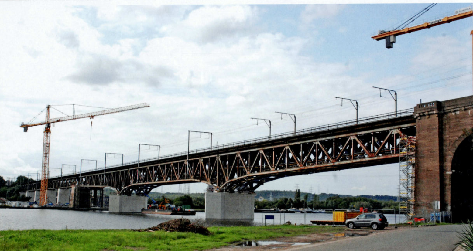
20 août 2017: le 'Pont des Allemands' à Visé, vu de la rive droite de la Meuse, en direction des Pays-Bas. Au premier plan, l'ancienne structure (reconnaissable à sa teinte rouillée par endroits) est encore en place, seule une des deux voies étant encore parcourable. La nouvelle travée enjambant la Meuse a déjà été posée derrière l'ancienne, sur les piles existantes. Photo: Jean Renard.
