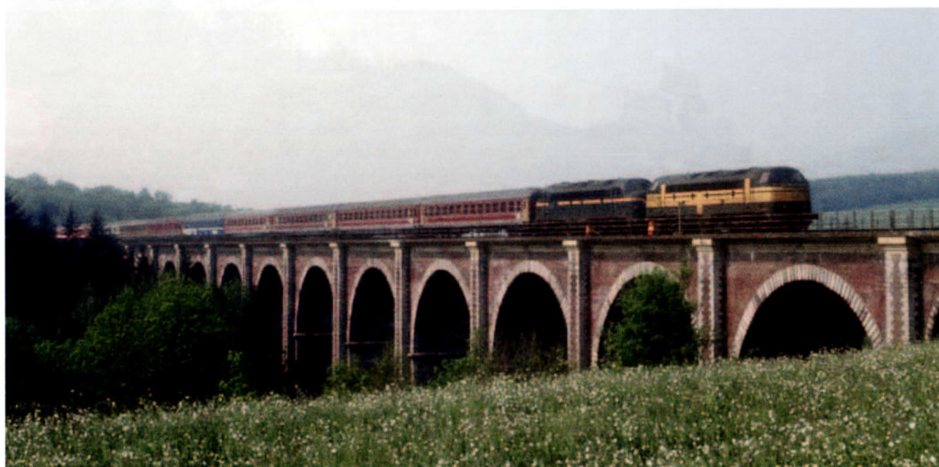
Pour remorquer le train lourd 296 'Edelweiss', les 5303 et 5320 furent mises à contribution en unités multiples. En route de Bertrix vers Namur, voici ce train franchissant le viaduc de Thanville, le 16 mai 1992. Photo : Max Delie.
