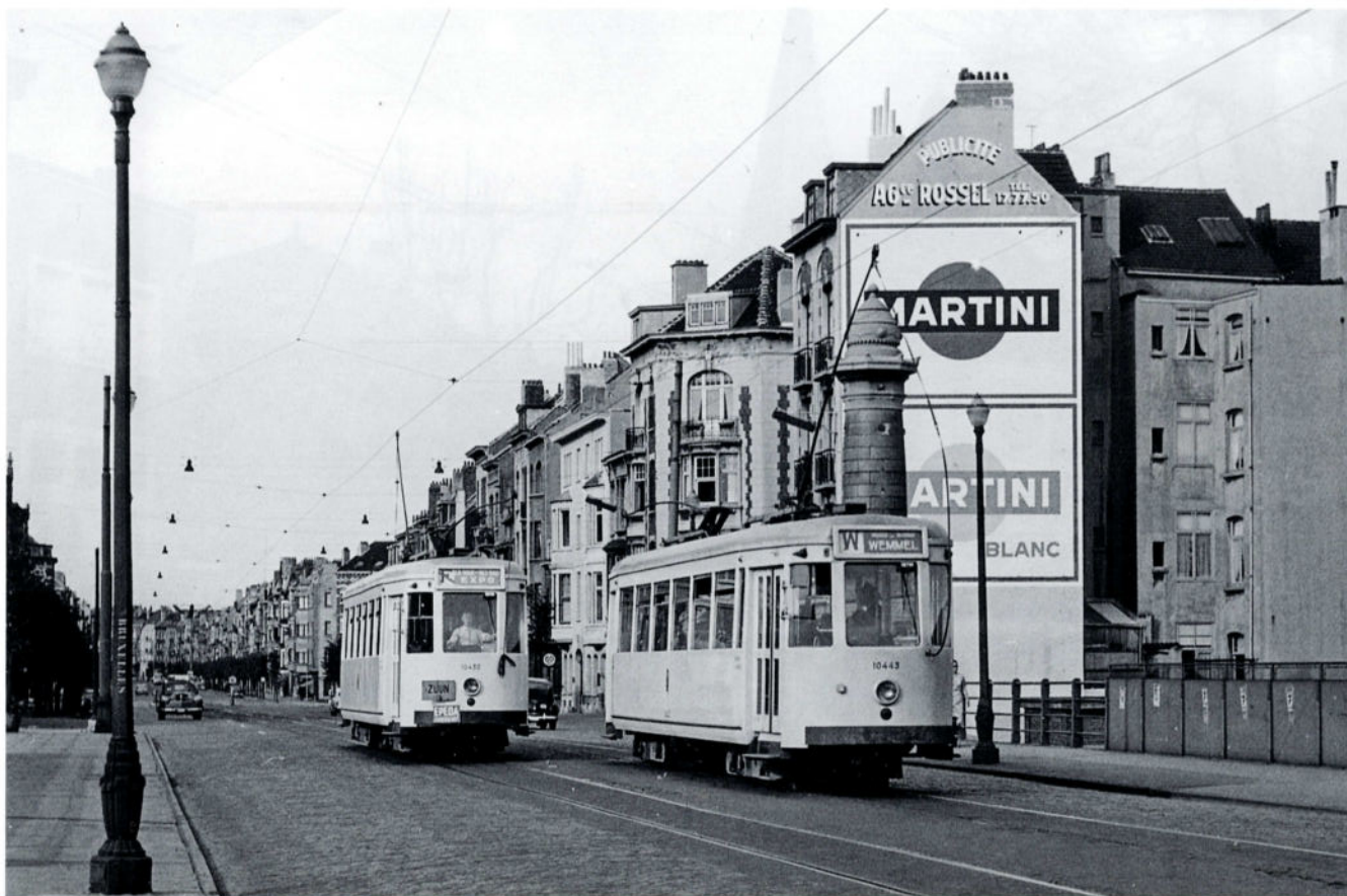
Deux motrices du type N se croisent au début de l'avenue Emile Bockstael à Laeken, le 17 août 1958. Elles franchissent toutes deux le pont surplombant l'entrée de la gare marchandises de Tour et Taxis. La 10430 à gauche assure un parcours supplémentaire avec film F barré entre le site de l'Expo '58 et Zuun, tandis que la 10443 à droite est en route vers Wemmel. La 10430 fut livrée en mars 1951 sous matricule 10434 et fut renumérotée quelques semaines plus tard en 10430. Ces deux motrices sont entretemps pourvues de baguettes antichocs sur leurs faces latérales et de nouveaux bogies 'élastiques'. La 10443 fut ferrailée dès 1960, suite à un accident. Quant à la 10430, elle subit le même sort, six ans plus tard. Photo : Frits van Dam - Collection Dirk Eveleens Maarse.
