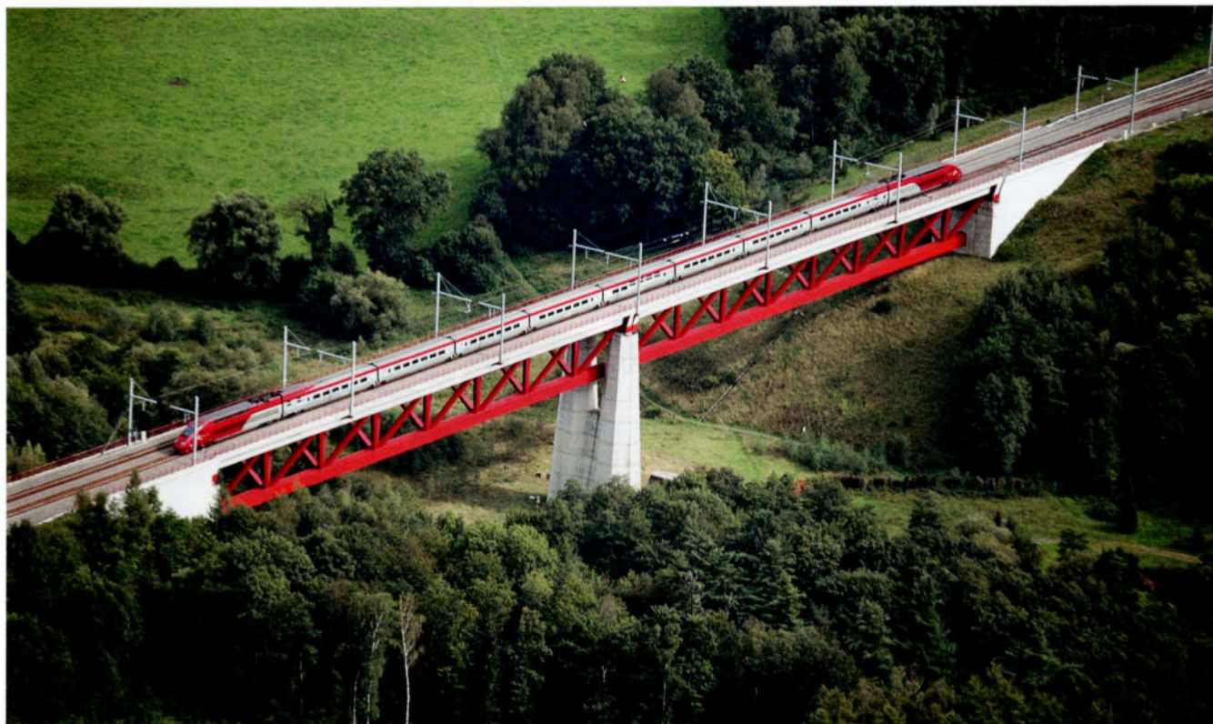
C'est avec plaisir que nous vous publions cette photo aérienne du Hammerbrücke à Astenet, que nous avons reçue de la SNCB : une rame Thalys PBKA franchit cet élégant ouvrage d'art le 1 er septembre 2006, en direction de Bruxelles. Photo : Infrabel - Collection Max Delie.
