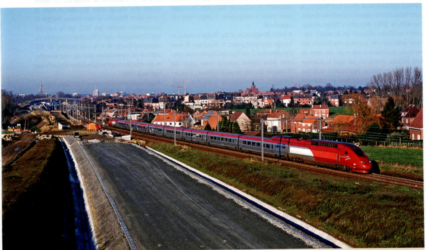
La rame PBKA 4307 quitte Louvain par la ligne 36, le 23 décembre 2000. En arrière-plan se trouve la bifurcation Molenbeek, où d'importants travaux sont en cours pour y établir l'assiette de la future ligne à grande vitesse n° 2 au-dessus des lignes 139 et 139A. A l'avant-plan par contre, cette assiette est quasi terminée. Photo : Carlo Hertogs.
