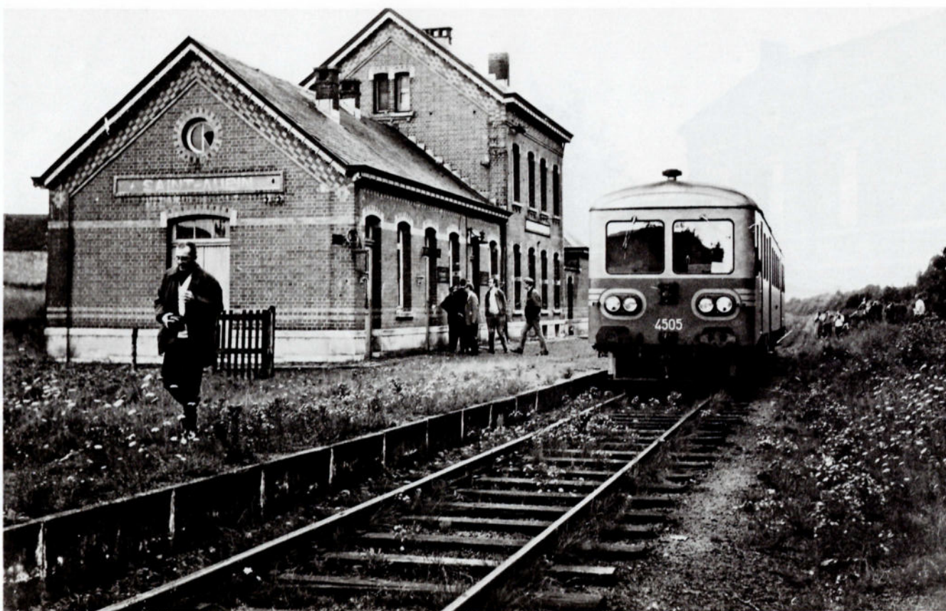
Saint-Aubin (L.136), le 19 août 1972: le bâtiment de la gare a déjà été reconverti en habitation particulière.
