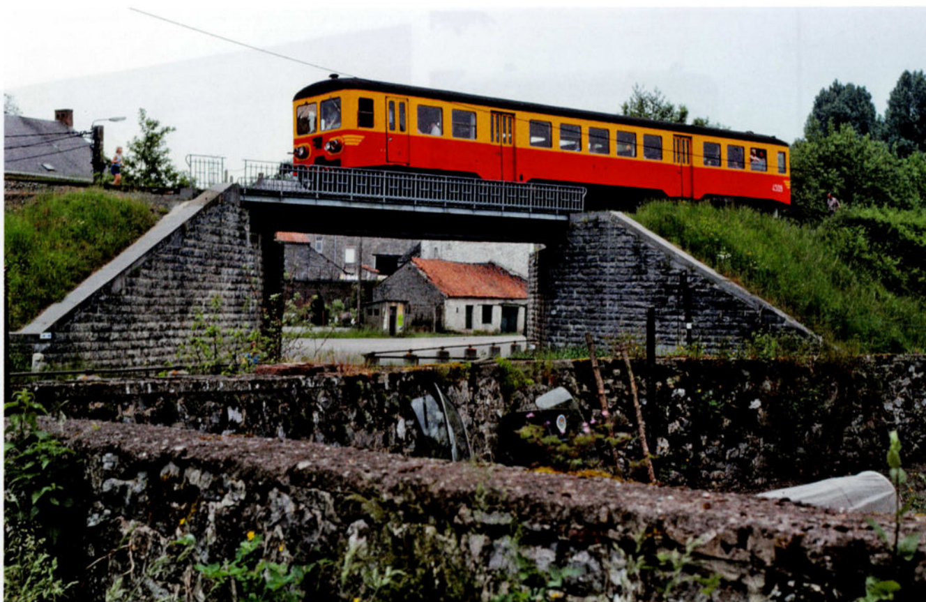
Le pont de la rue Fagneton à Florennes (L.136), le 3 juin 1978. La démolition du tablier compliquerait une réactivation de cette ligne jusque Florennes, dans le cadre d'une extension (éventuelle) de la desserte d'une nouvelle carrière: nous y reviendrons.
