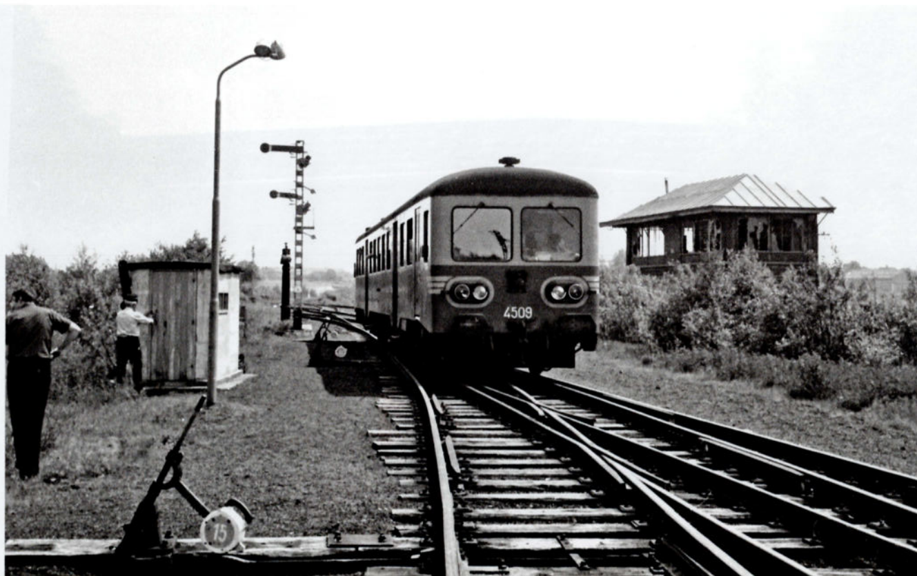
Florennes-Central (côté 'Est'), le 3 juin 1978. L'autorail spécial du GTF arrive de Stave (L.136A). A droite, l'ancienne cabine abandonnée; à gauche, l'abri du petit bâti de manœuvre des signaux mécaniques d'entrée et de sortie, les aiguillages se manœuvrant à pied d'œuvre.
