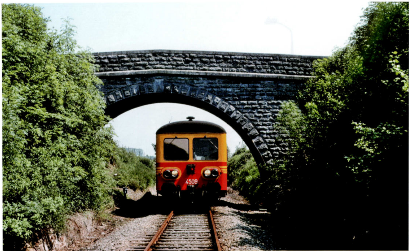
Quelque part le long de la ligne 136A entre Ermeton-s/Biert et la bifurcation Stave: un pont d'époque en pierres de taille, le 3 juin 1978.
