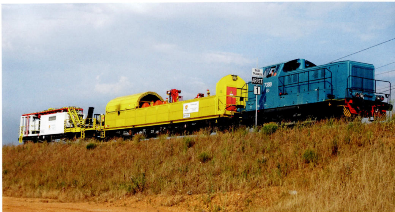
La 7389 pousse un train d'électrification de Colas Rail, composé de wagons normalement basés à Enghien (en Belgique). Le convoi s'engage sur le raccordement 'sud' de la nouvelle ligne, en direction de la base-travaux.
