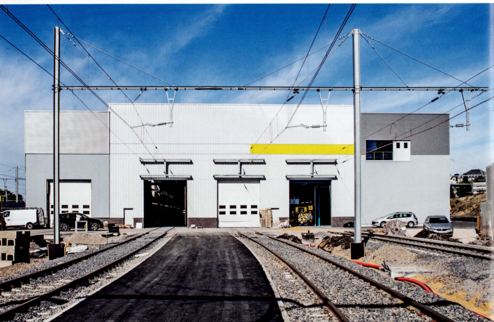
La façade du nouvel atelier de traction d'Arlon. Photo: SNCB.
