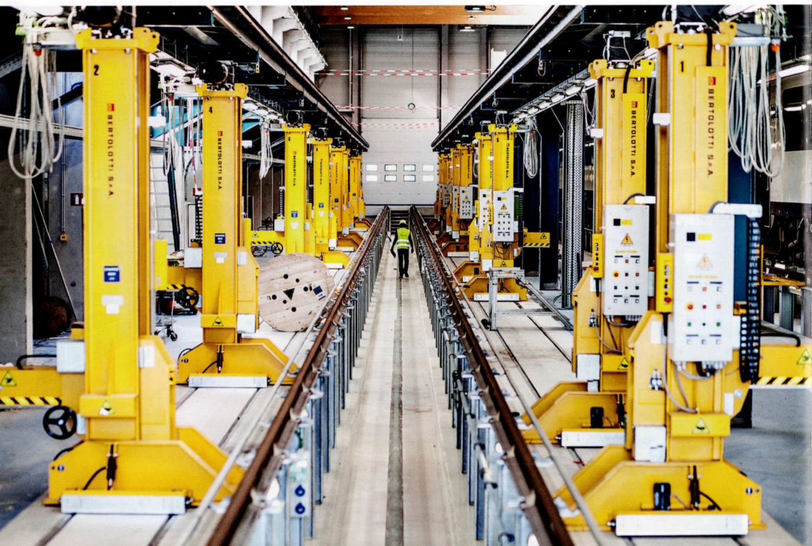
Les appareils de levage les plus modernes sont présents en nombre pour lever les caisses des engins. Photo: SNCB.
