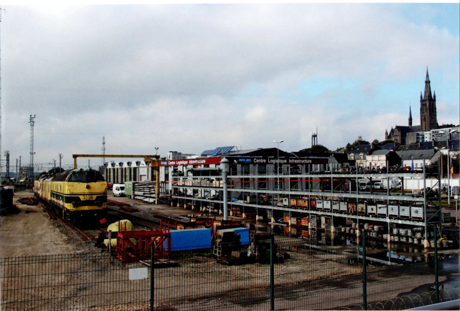
Le nouvel atelier de traction d'Arlon voisine avec le nouveau CLI (Centre Logistique Infrastructure) d'Infrabel. Remarquez l'antique grue hydraulique, au centre de l'image! Photo: Jean Lechat.
