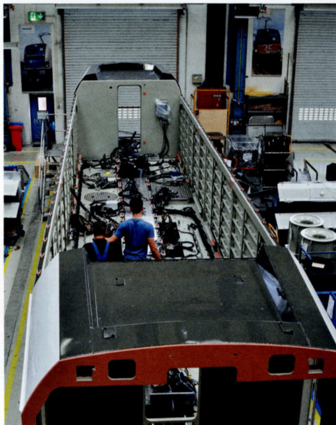
Une vue illustrant la pose des câbles à bord dans une caisse vide: le plancher du couloir central a déjà été posé, ainsi que les couvercles de certaines ouvertures.
