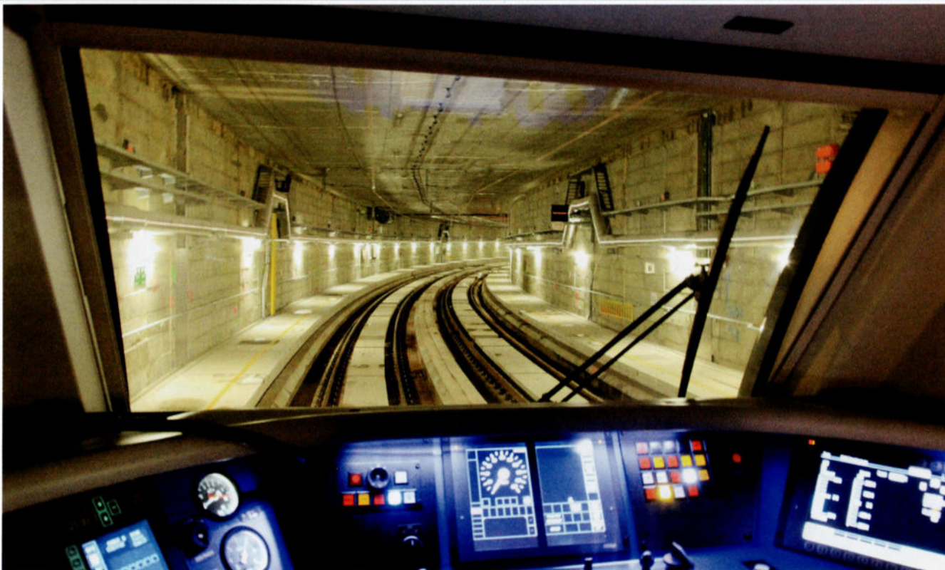
Le tunnel Schuman - Josaphat, vu depuis la cabine de conduite de la 08144. Remarquez le type particulier de l'assiette des voies: elle a été conçue pour absorber les vibrations provoquées par la circulation des convois.
