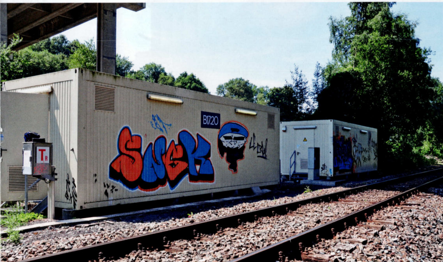
Le container dans lequel se trouve le poste de signalisation d'Yves-Gomezée.
