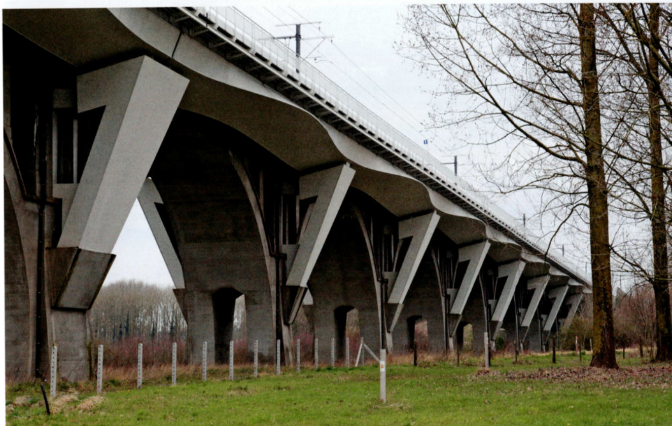
Cette photo illustre comment les nouveaux tabliers supportant les deux voies supplémentaires de la ligne 50C ont été fixés au viaduc existant de la Pede.
