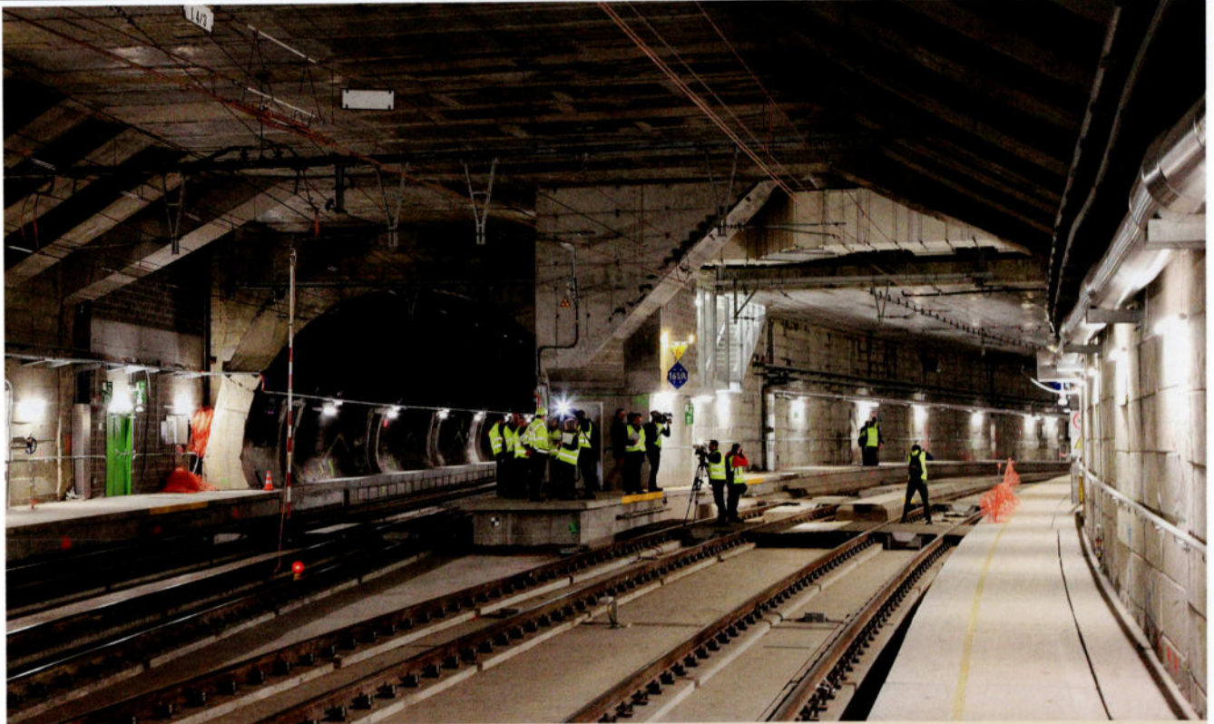
La nouvelle bifurcation 'Parc du Cinquantenaire' est dans le dos du photographe. À gauche, le tunnel existant de la ligne 26; à droite, l'origine du nouveau tunnel Schuman - Josaphat.
