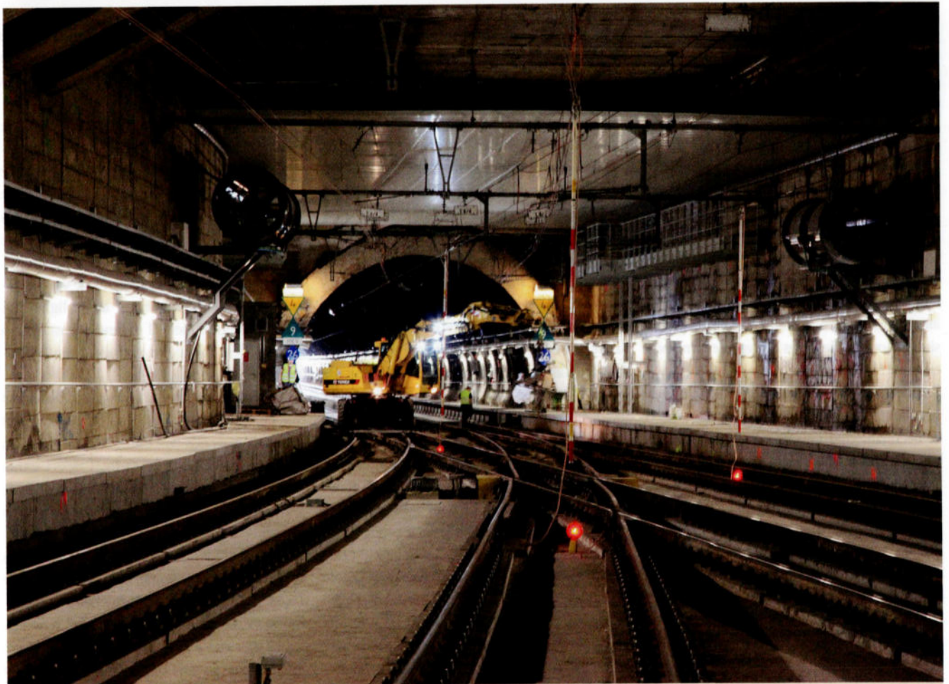
La nouvelle bifurcation 'Parc du Cinquantenaire', où une grue rail-route effectue les derniers travaux avant la mise en service commerciale du tunnel. Derrière la grue se situe la partie 'Nord' de la ligne 26.
