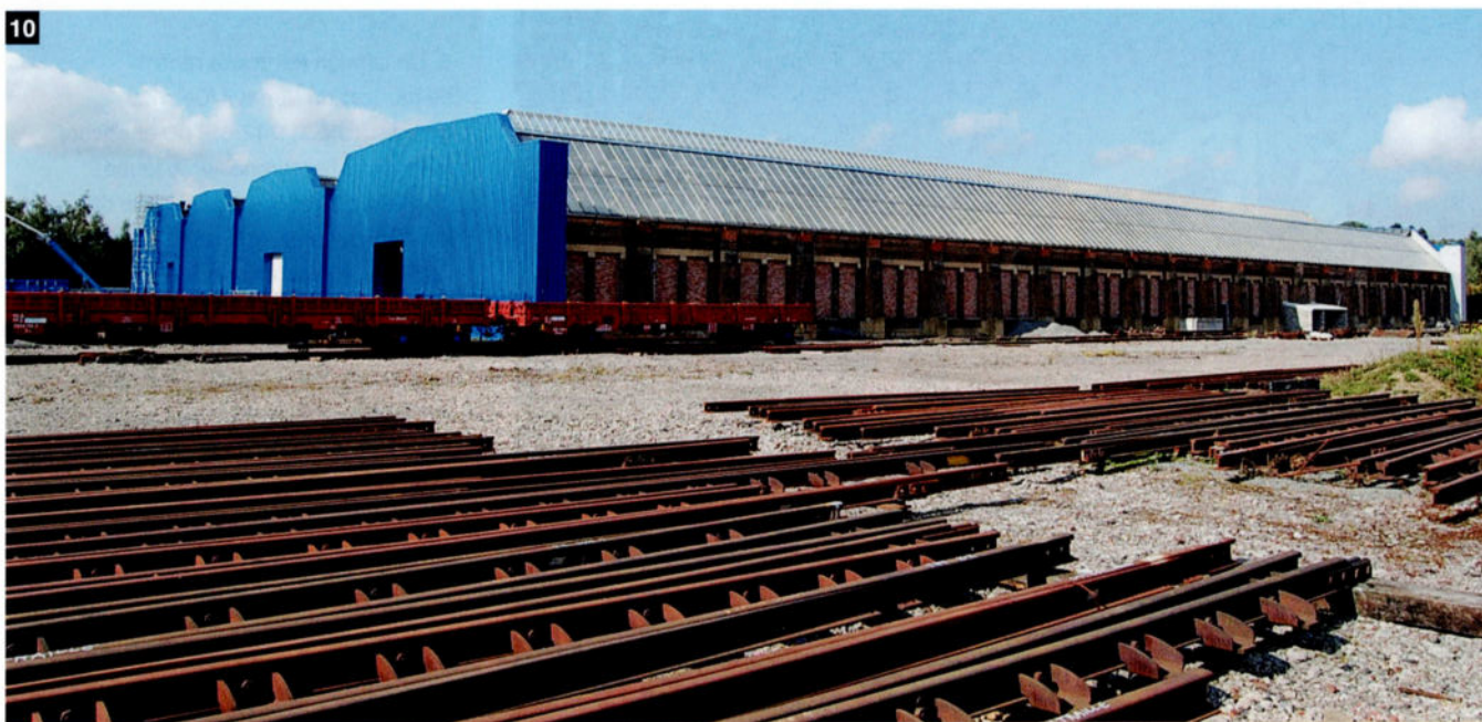
10. Autre bâtiment historique joliment restauré à Ronet: l'ancien atelier de réparation des wagons, qui jouxtait l'atelier de traction SNCB. Ce bâtiment a été reconverti avec bonheur en un vaste garage-entrepôt, qui abrite désormais les nombreux véhicules routiers utilisés par Infrabel.
