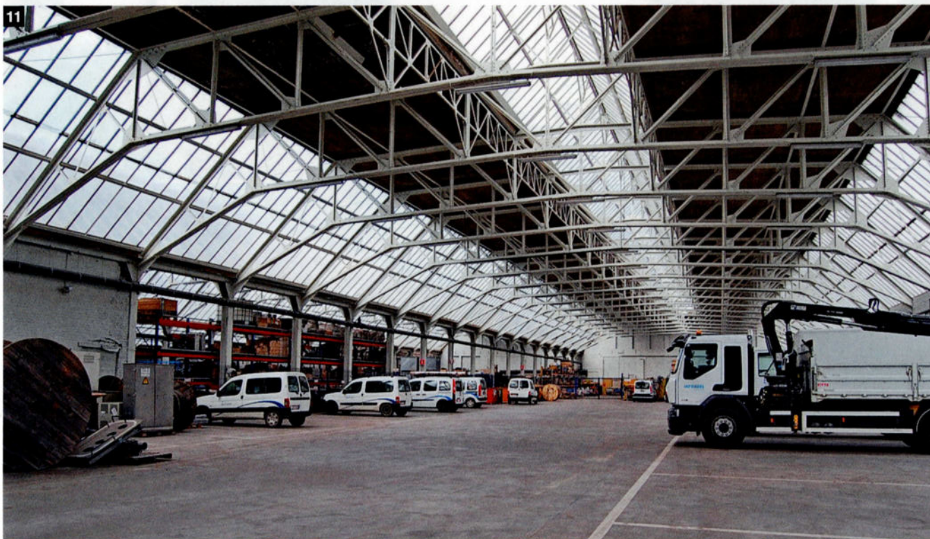
11. Une vue intérieure du garage-entrepôt du CLI de Ronet, établi dans l'ancien atelier de réparations des wagons. La belle charpente métallique de cet édifice le rend étonnamment lumineux à l'intérieur.
