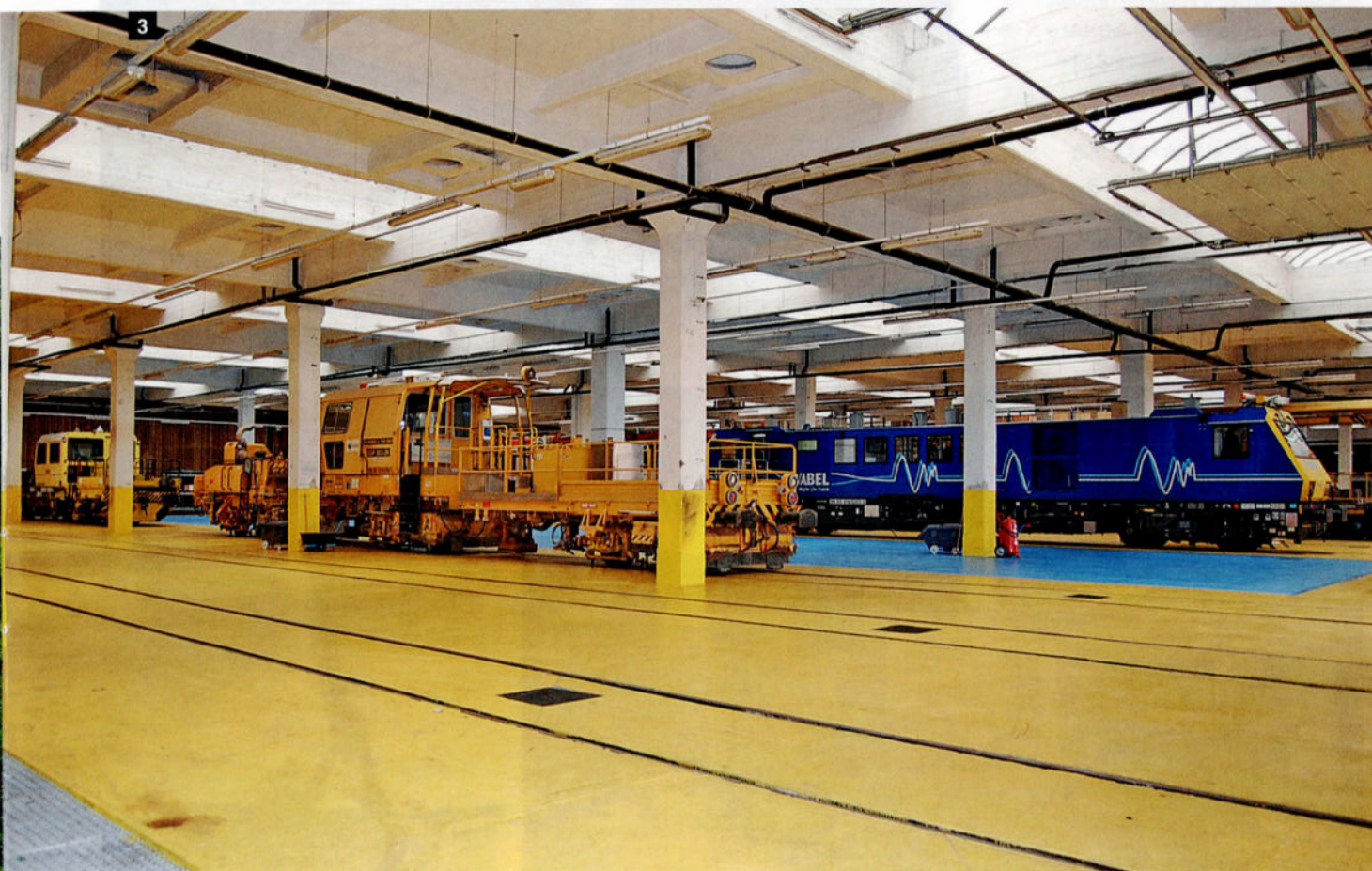
3. L'intérieur du hall de maintenance du CLI de Ronet, d'une propreté exemplaire: quel contraste avec l'époque où ce lieu servait d'atelier de traction à la SNCB. A gauche, une des huit régaleuses de ballast du type SSP 203 de fabrication Plasser & Theurer. A droite, l'autorail EM203 de fabrication Geismar, destiné au contrôle périodique du bon fonctionnement des balises ETCS et TBL1+.
