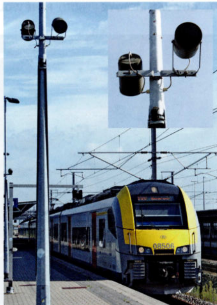
Sur les quais des gares belges, les haut-parleurs sont souvent fixés aux mâts d'éclairage. Gare de Noorderkempen; août 2016. (Photo: Guy Van Meroye).
