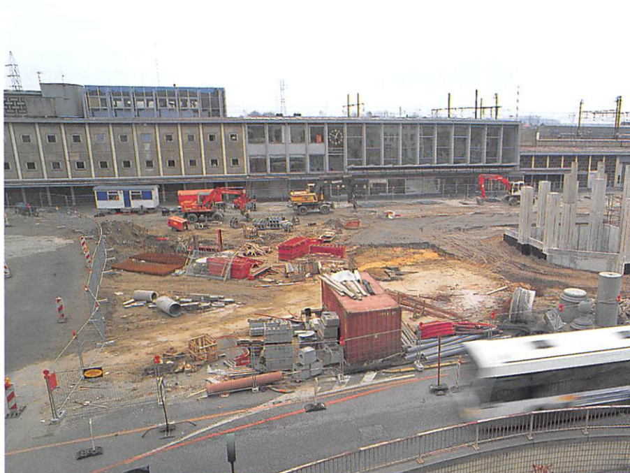
Werken aan het vernieuwde stationsplein te Mechelen
