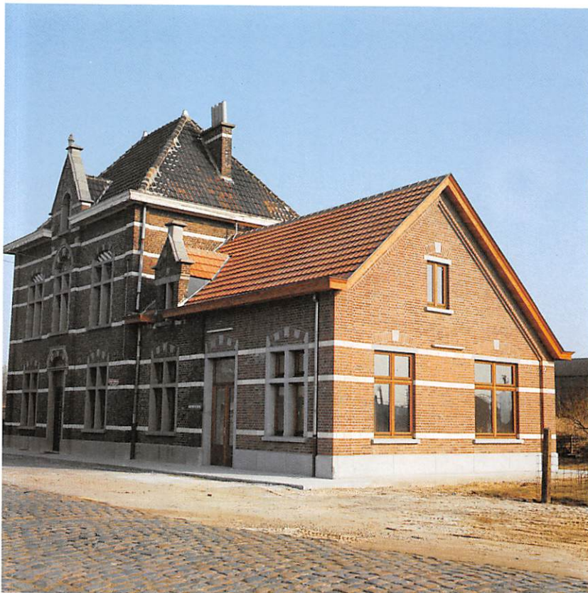
De kantoren van de stelplaats te Tienen, vóór en na de uitbreidingswerken.
