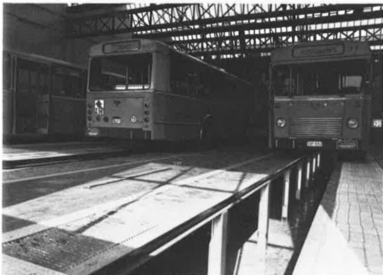
5. De drie nieuwe schouwputten voor gelede bussen waren afgewerkt op 28.12.1981.
