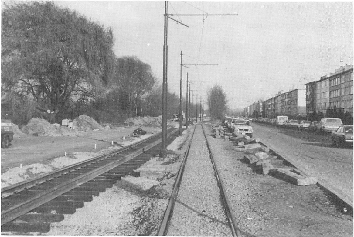
Verlenging tramlijn 12, Ter Heydelaan Deurne, 15.11.1981; zicht richting Wim Saerensplein; in 't midden van de foto : het bestaande maneuverspoor, links het nieuwe spoor richting stadscentrum. Foto E. Keutgens
