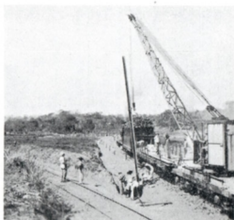
Levage et implantation des poteaux. (Photos B.C.K.)
