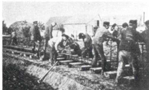
Juillet 1915. — Construction de la ligne Adinkerke-Leysele.
