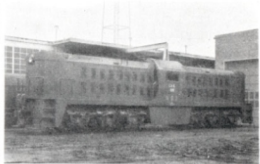
Locomotive diesel-électrique CC Whitcomb du B.C.K. - 1350 CV. (Photo Whitcomb.)
