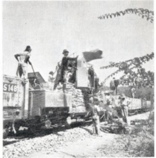
Train de bétonnage des massifs des poteaux. (Photos B.C.K.)
