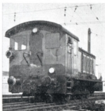
Locomotive diesel - hydromécanique type 23.100 de la S.N.C.B. - 360 CV. - 60 km/h. (Photo S.N.C.B.)
