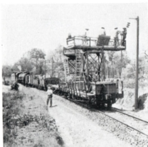
Train d'habillage des supports.
