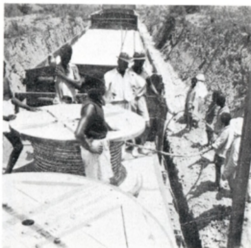
Train de déroulage du câble téléphonique. (Photo B.C.K.)
