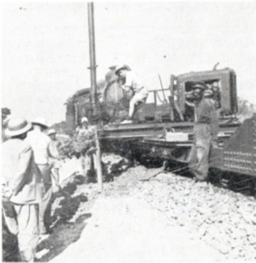
Foreuse pour fondation des poteaux de caténaire.
