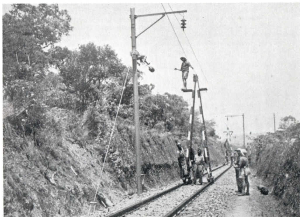
Réglage de la caténaire après pendulage.
